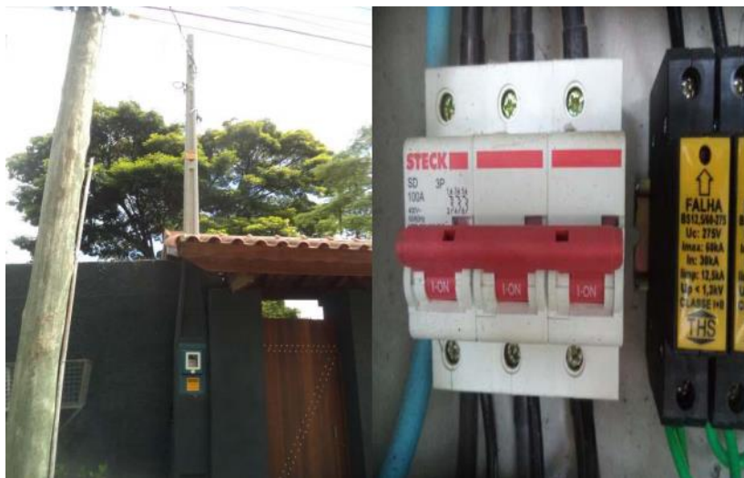
Figura 9 – Foto do padrão de entrada da instalação fotovoltaica
