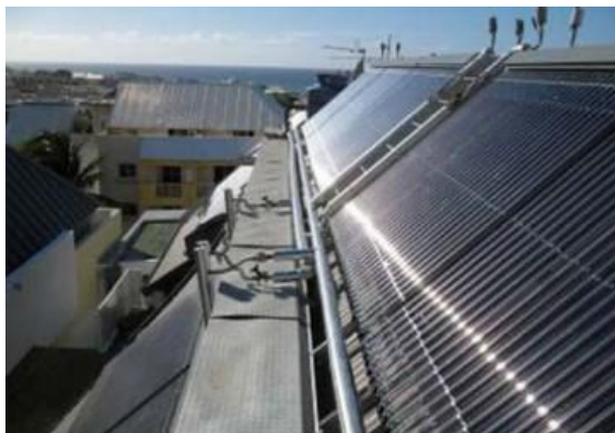
Figura 17 – Coletores solares do edifício Saint Dennis de la Réunion-França
