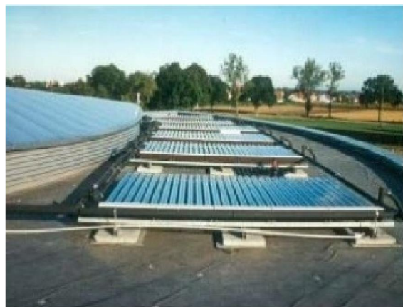
Figura 16 – Disposição dos coletores solares no prédio da Ott Ingenieure, em Langenau, na Alemanha
