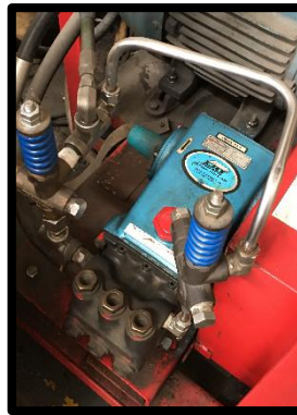
Figura 27 - Manutenção corretiva da bomba do teste
