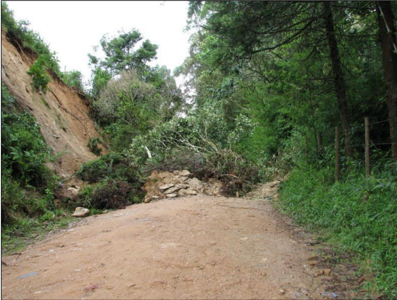
Figura 20 – Deslizamento de terra no bairro da Barra do Bié – Cunha, que bloqueou estrada vicinal em decorrência dos eventos de 01/01/2010
