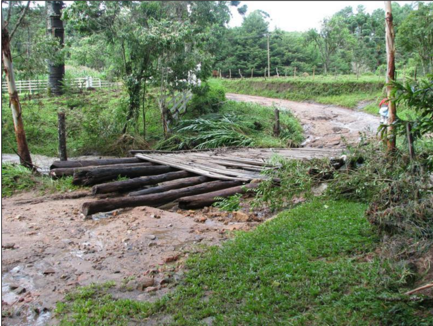
Figura 21 – Restos de ponte do bairro da Barra do Bié – Cunha, devido enchente oriunda dos eventos de 01/01/2010
