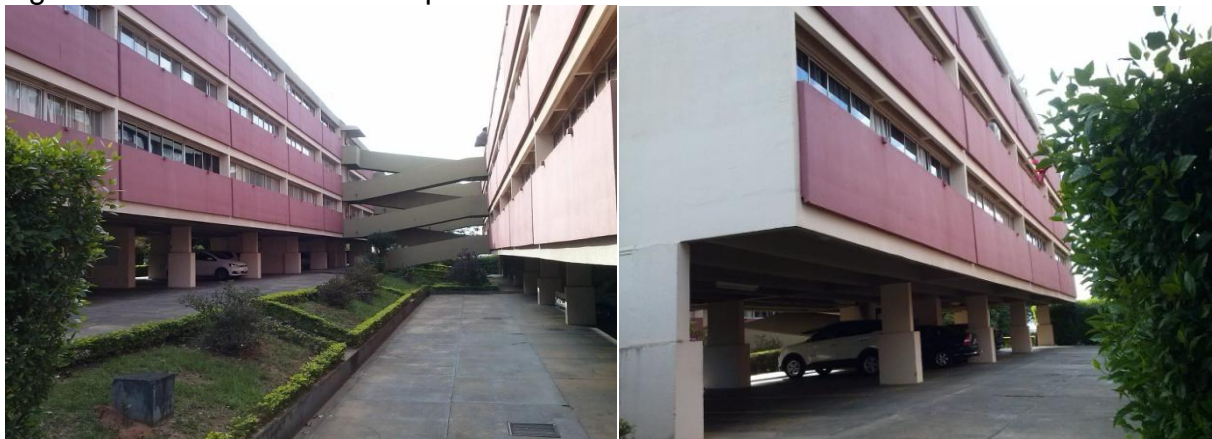
Figura 12- Pátio central e rampas
