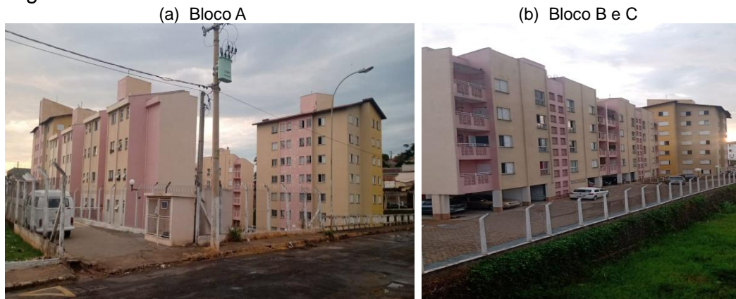
Figura 19- Fachada dos edifícios
