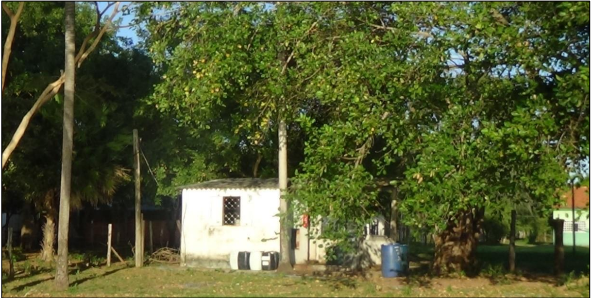
Figura 31: Gerador de energia.
