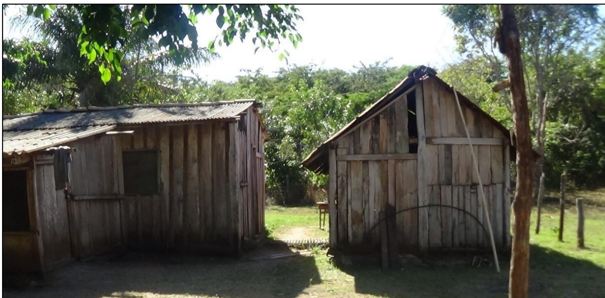
Figura 35: Casa Guató de telha de amianto
