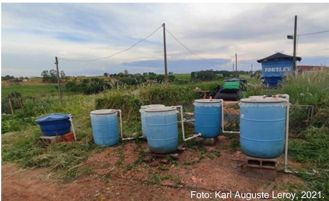
Figura 7 - Sistema de tratamento de água residuária instalado no Campus da FCA Unesp, Botucatu
