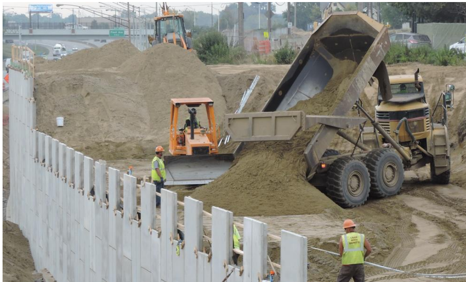
Figura 14: Enchimento com solo para contenção em Terra Armada.
