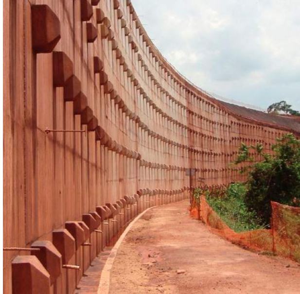
Figura 15: Contenção em cortina atirantada.
