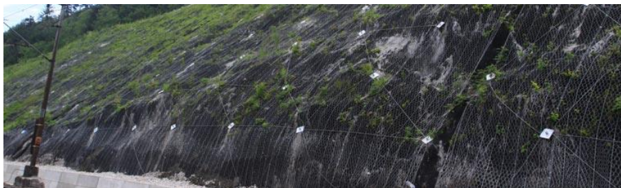
Figura 9: Exemplo de aplicação da tela de alta resistência.
