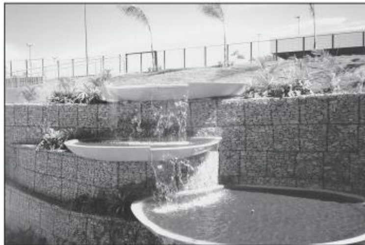
Figura 2: Muro de gabião.
