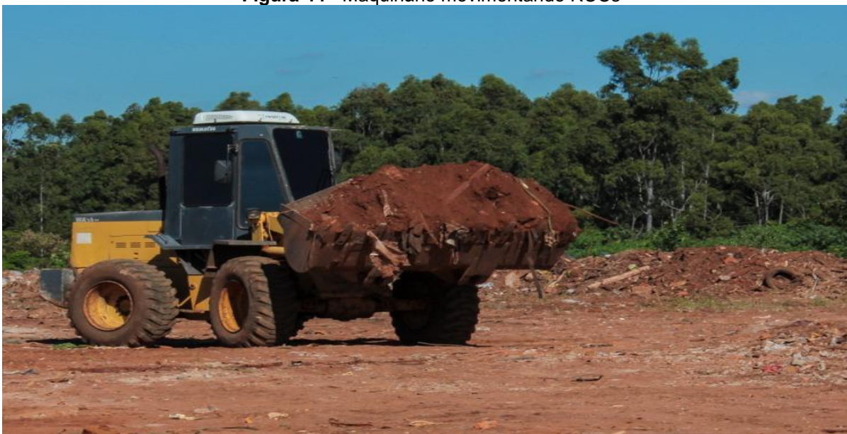
Figura 44 - Maquinário movimentando RCCs
