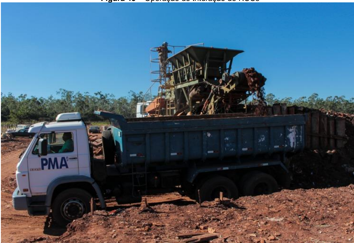
Figura 45 – Operação de trituração de RCCs
