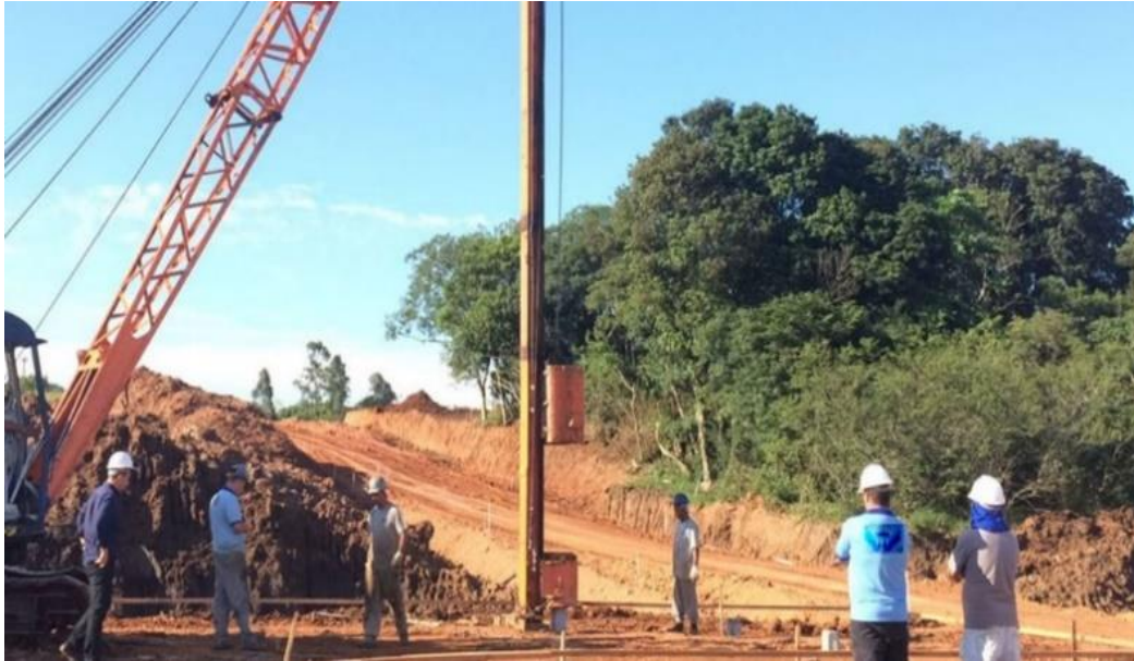
Figura 1 - Sondagem a percussão.
