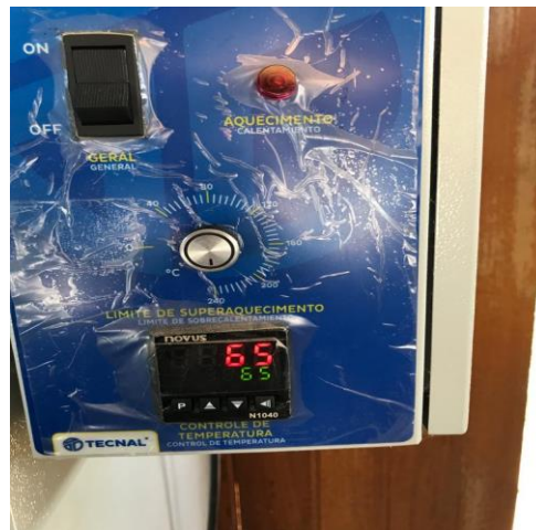
Figura 6 : Ventilação de ar forçada
