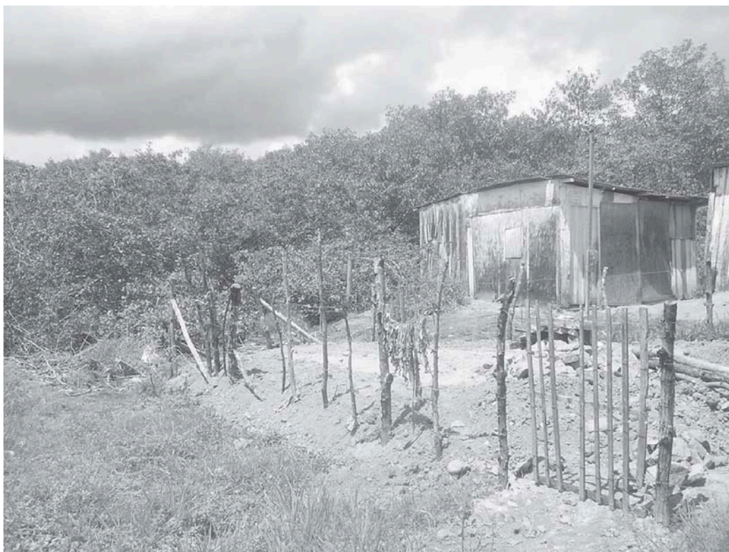
FIGURA 4. Aterro e construção sobre o manguezal.
