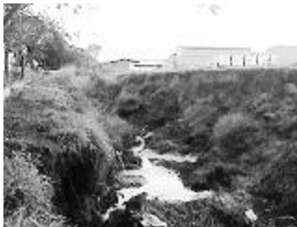
FOTO 1: Processos erosivos laterais na Alta Bacia do Ribeirão Tijuco Preto a montante do setor canalizado. Autor: Silveira, A.
