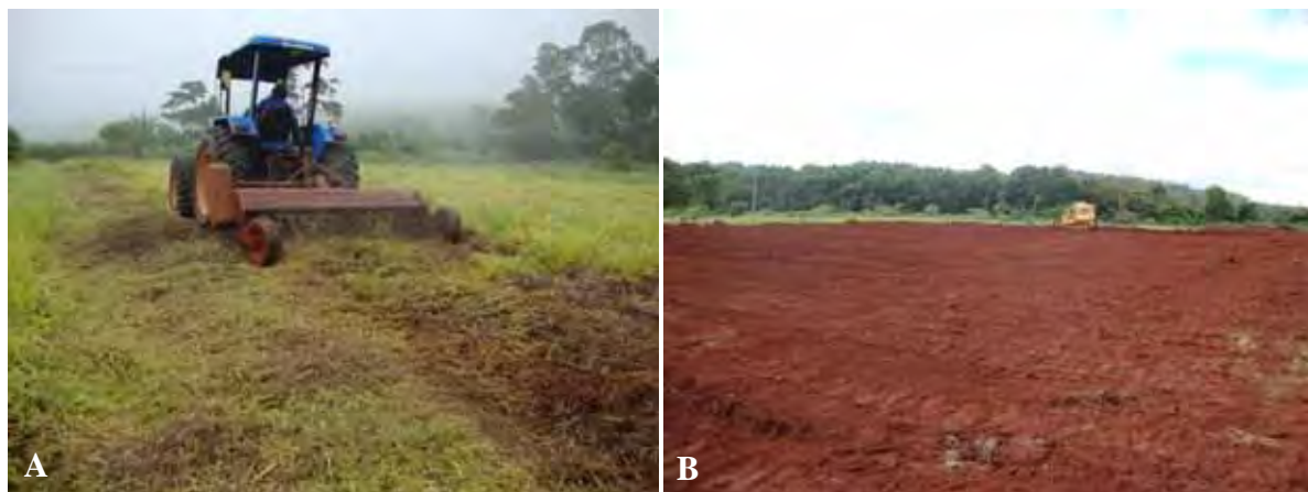
Figura 5. Limpeza da área experimental com roçadeira (A) e nivelamento utilizando máquina de esteira (B)
