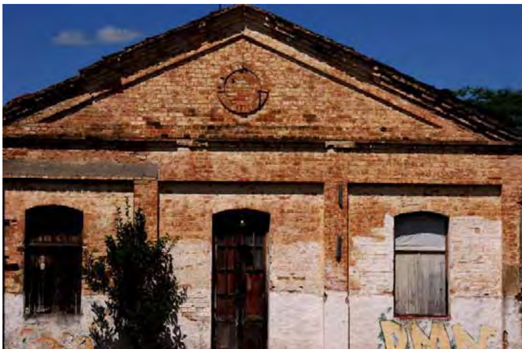
Antigo galpão da estação de Guaratinguetá
