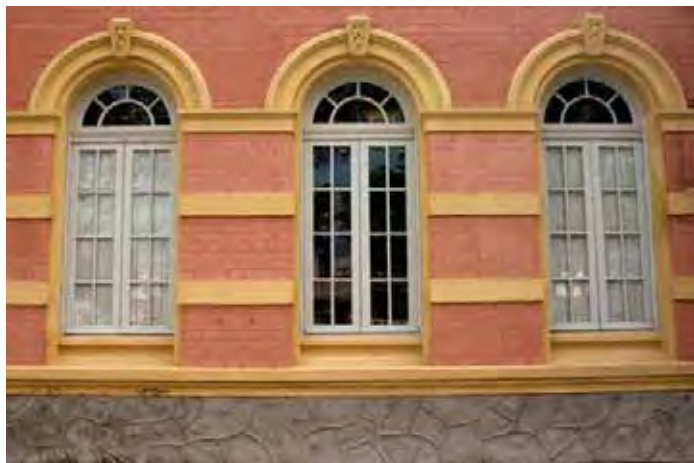
Figura 96 – Arco posterior, arco interno de uma abertura que é menor em tamanho do arco externo, arco ornamento chamando arco rompido ou interrompido. Foto de Vanessa Stollar, 2009.
