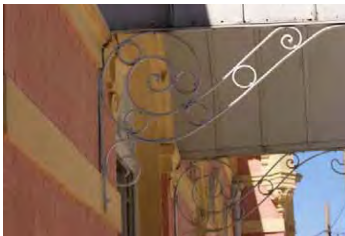
Figura 95 – Mão Francesa elemento estrutural em balaço com marquises. Ferro fundido decorado com movimentos circulares. Foto de Vanessa Stollar, 2009.
