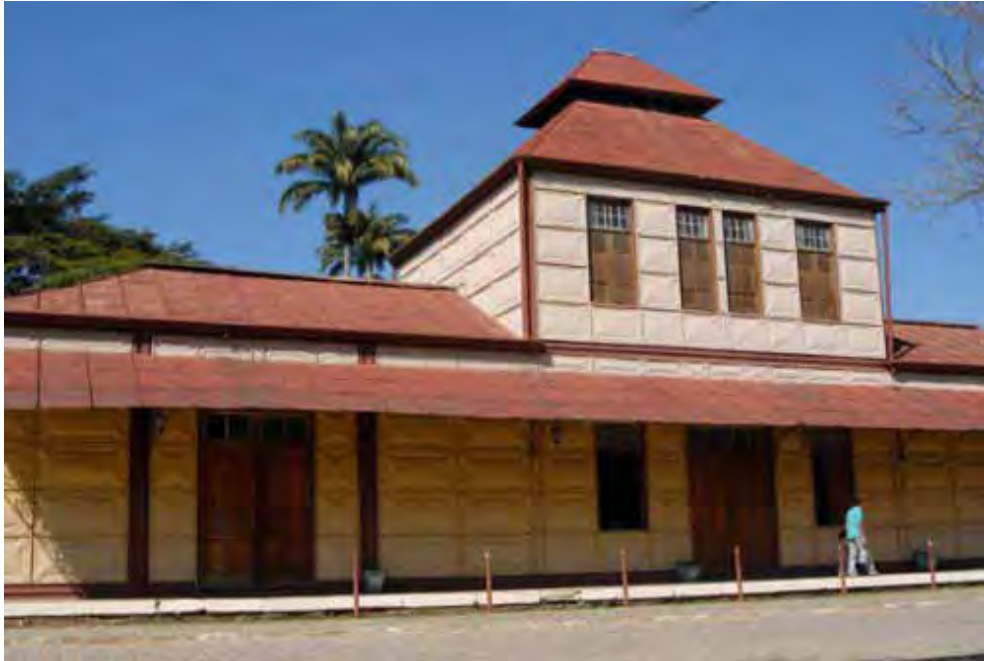
Figura 68 – Foto da Estação de Bananal em 2007. Foto Claudio Laranjeira. Disponível em: < www.estacoesferroviarias.com.br >. Acesso em: 13 abr. 2009.
