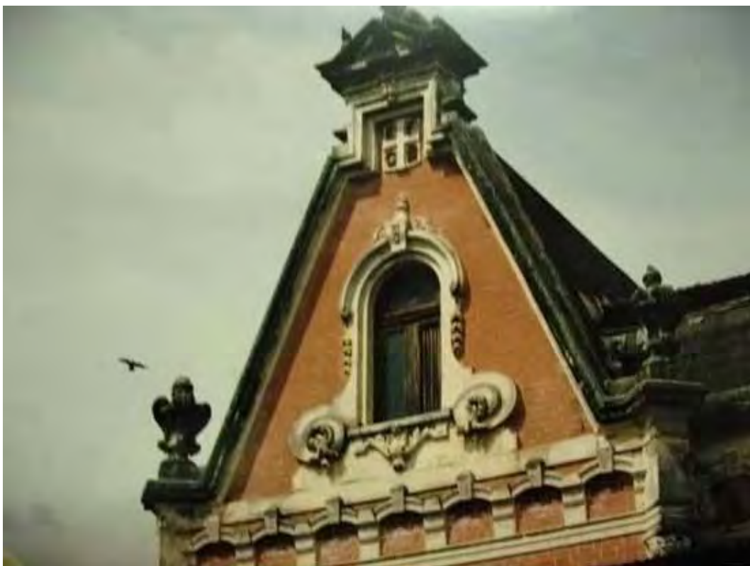
Estação antes do restauro
