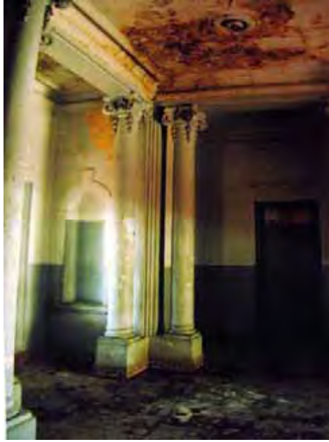
Figura 26 – Foto do interior da Estação de Guaratinguetá nos anos 90. Arquivo do Museu Frei Galvão.
