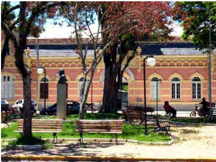
Figura 28 – Estação de Guaratinguetá após a restauração. Foto de Vanessa Stollar, 2009.
