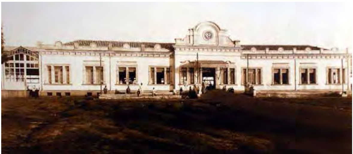
Figura 46 – Foto da Estação de Dois Córregos, 1912. Fonte: Museu da Companhia Paulista/complexo FEPASA, Jundiaí.
