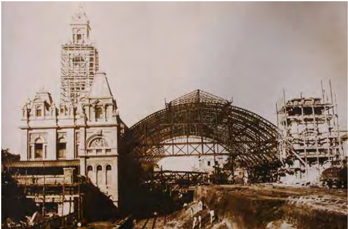
Figura 49 – Foto da Estação da Luz em construção, 1900, Guilherme Gaensly/Fundação Patrimônio Histórico de Energia de São Paulo.
