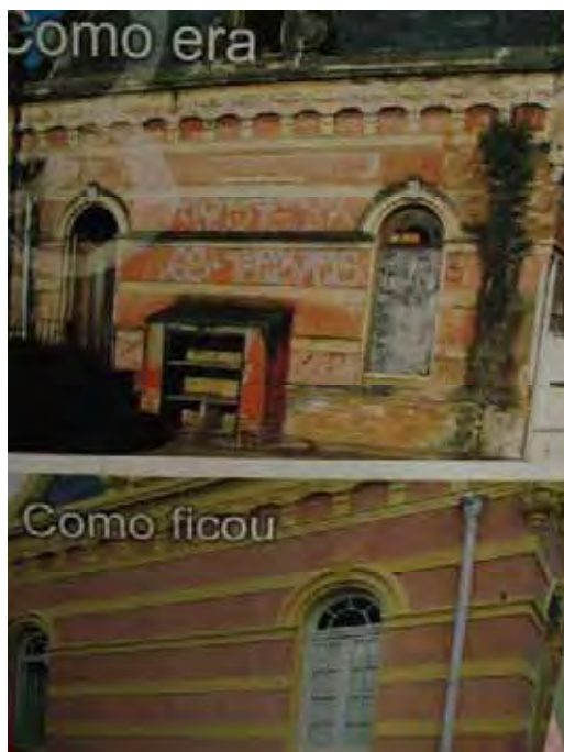
Figura 99 – Imagem que consta na documentação sobre o processo de restauro da estação de Guaratinguetá. Fonte Museu Frei Galvão.
