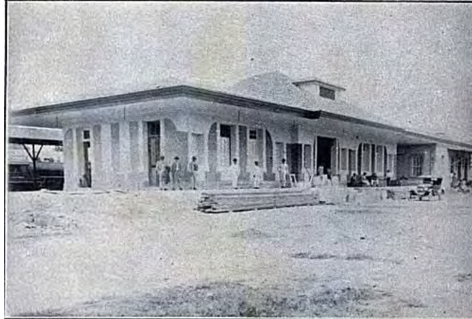
Figura 33 – A estação atual, em fase de acabamento, em foto de 1924/25. Do lado direito, ainda se pode ver o prédio original. Foto do relatório da EFCB de 1925, cedida por Jorge Ferreira.
