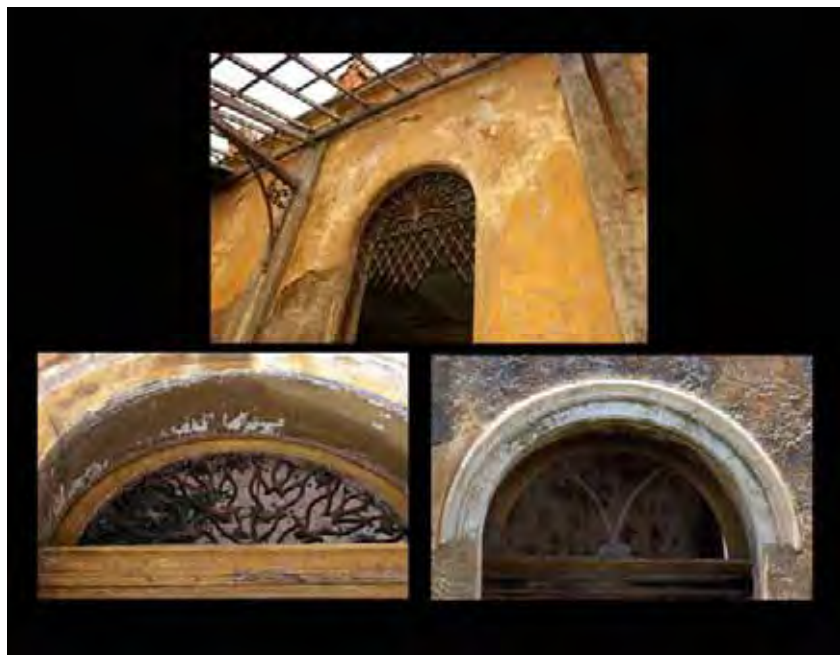
Figura 78 – Detalhes das janelas da Estação de Cachoeira Paulista. Foto de Vanessa Stollar, 2009.
