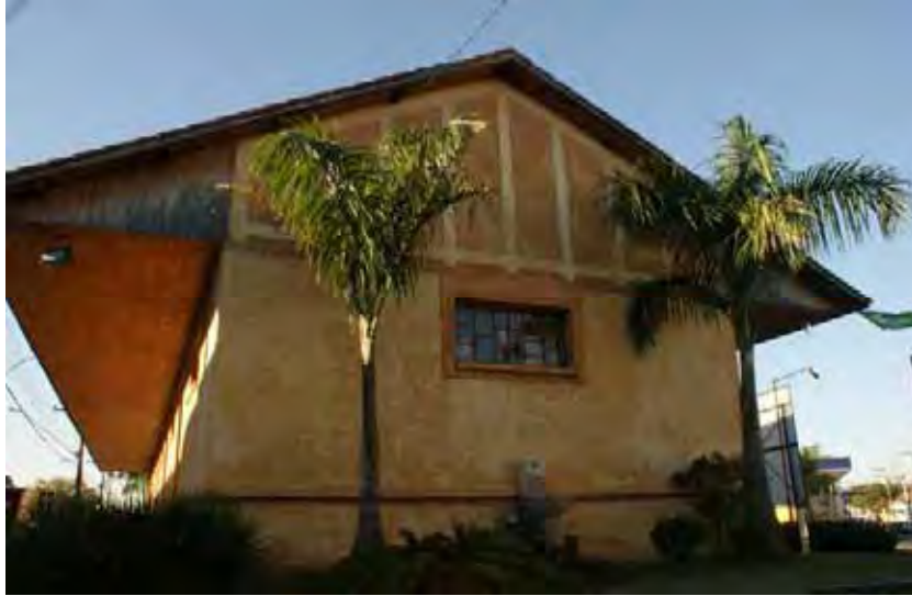
Figura 38 – Foto do antigo armazém da estação em Jacareí, atual núcleo de Arqueologia da cidade. Foto de Vanessa Stollar, 2009.
