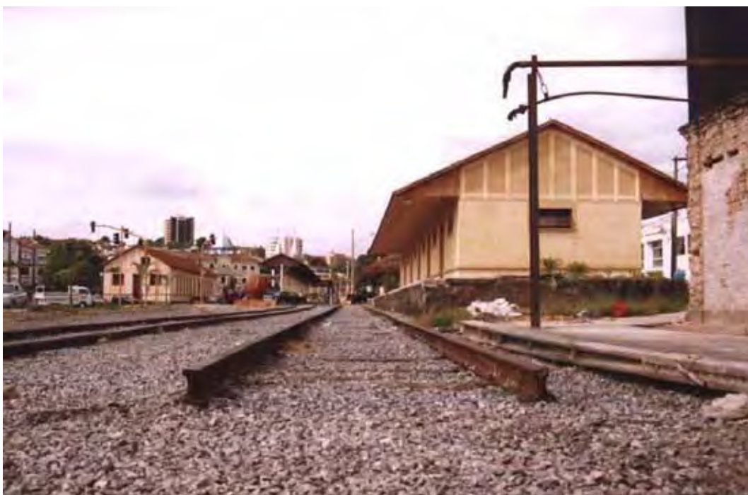
Estação sem parte dos trilhos e plataforma, 2009
