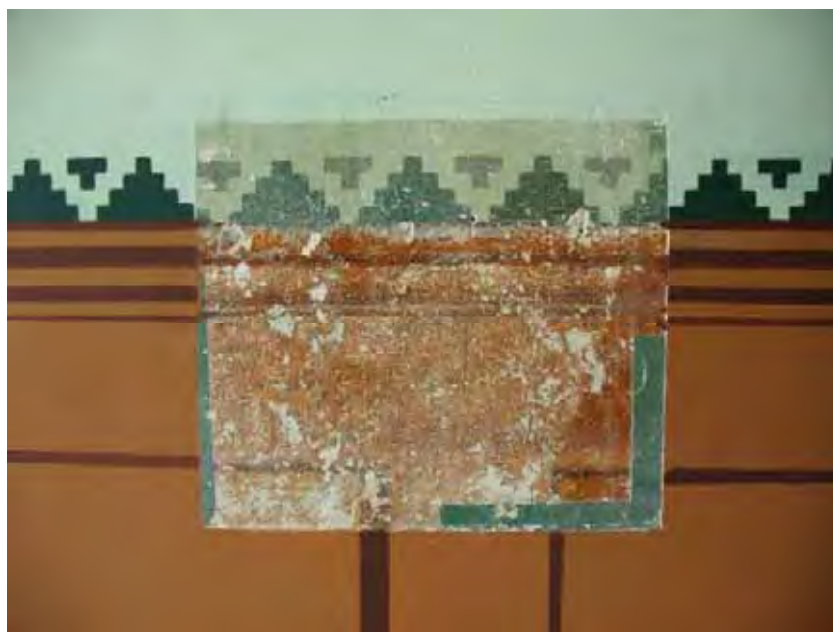
Figura 102 – Foto da parede interna da estação de Guaratinguetá que evidencia a restauração feita na estação, mostrando a antes e depois. Foto, Vanessa Stollar, 2009.
