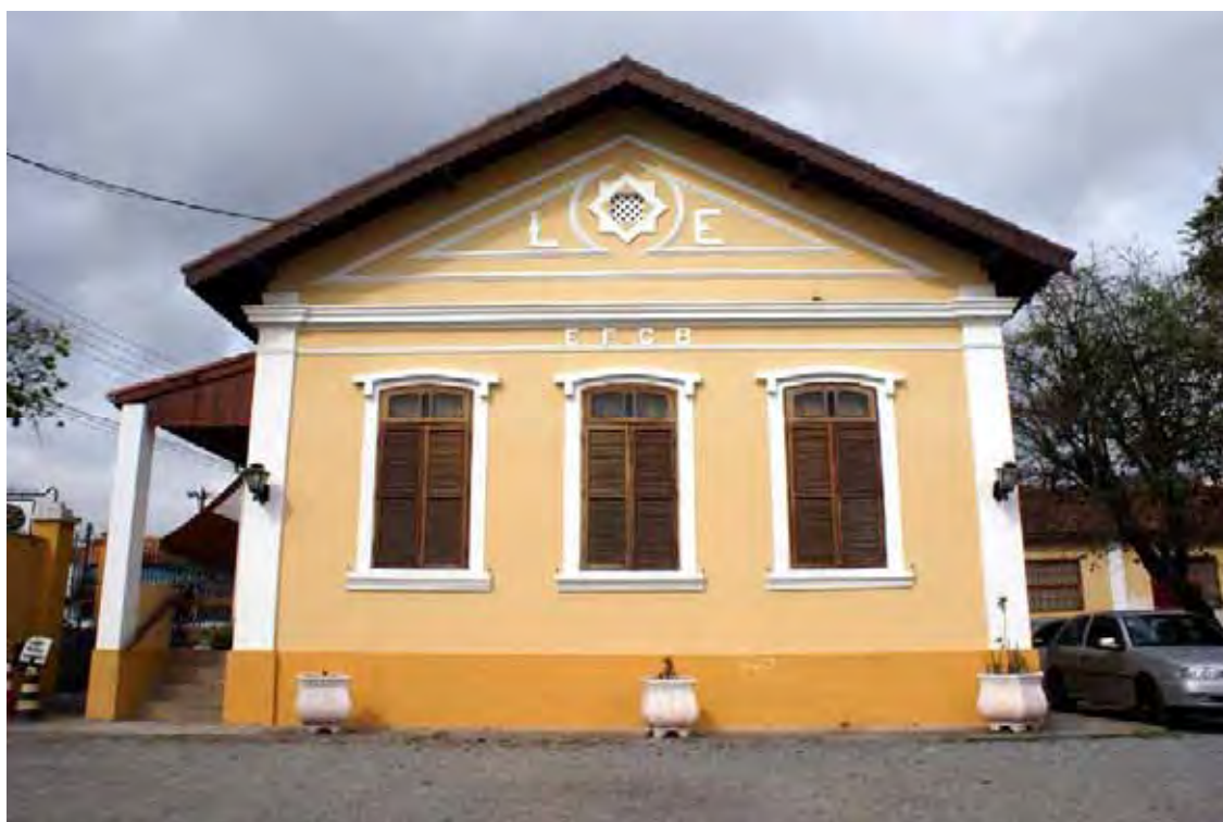
Figura 91 – Foto da residência do engenheiro ferroviário. Foto de Vanessa Stollar, 2009.
