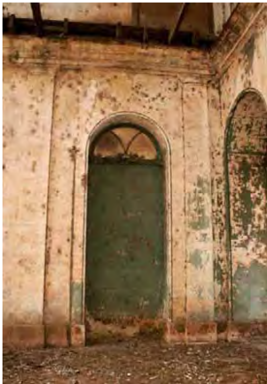
Figura 82 – Foto do interior da estação, mostrando restos da pintura. Estação de Cachoeira Paulista. Foto de Vanessa Stollar, 2009.
