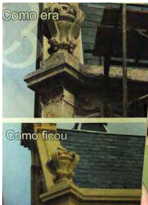
Figura 101 – Imagem que consta na documentação sobre o processo de restauro da estação de Guaratinguetá. Fonte Museu Frei Galvão.
