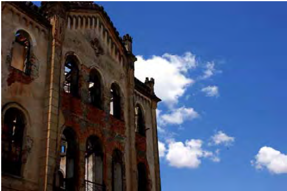
Figura 19 – Detalhe da Estação de Cachoeira Paulista. Foto de Vanessa Stollar, 2009.
