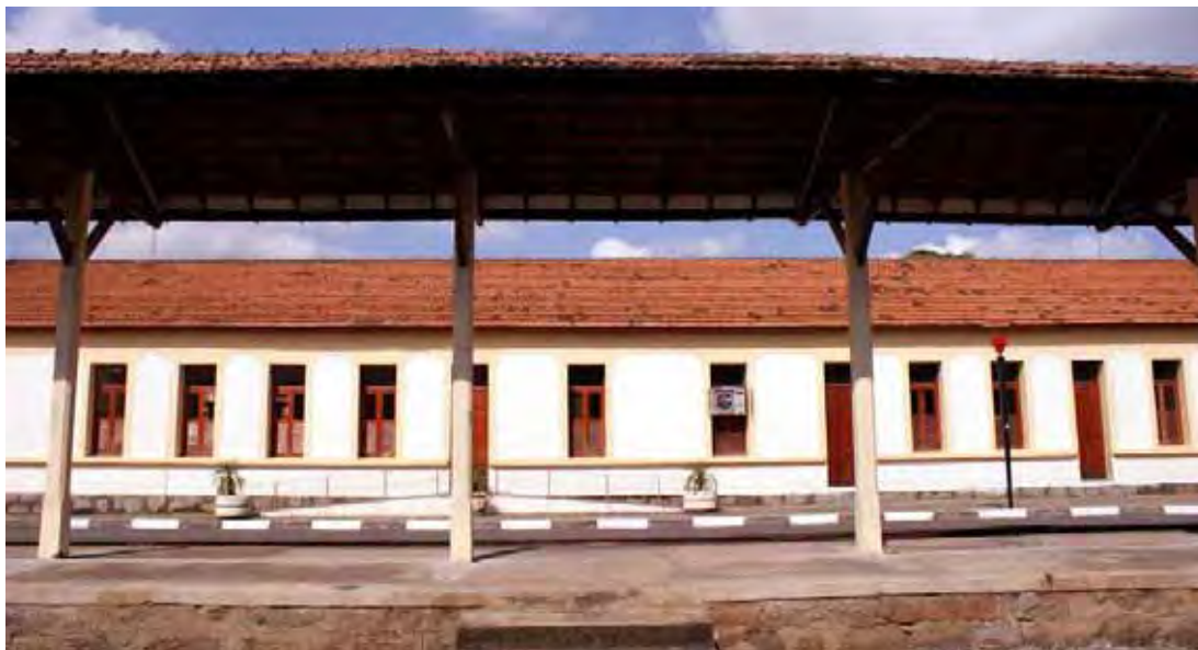
Figura 104 – Foto do antigo prédio destinado a dormitório de funcionários da EFCB. Atual Sala Mario Lago. Foto de Vanessa Stollar, 2009.
