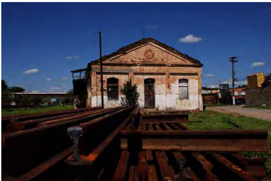
Antigo galpão da estação de Guaratinguetá
