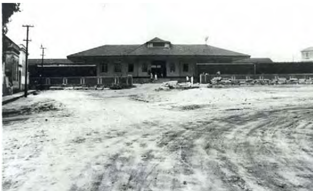
A segunda estação em construção, 1924
