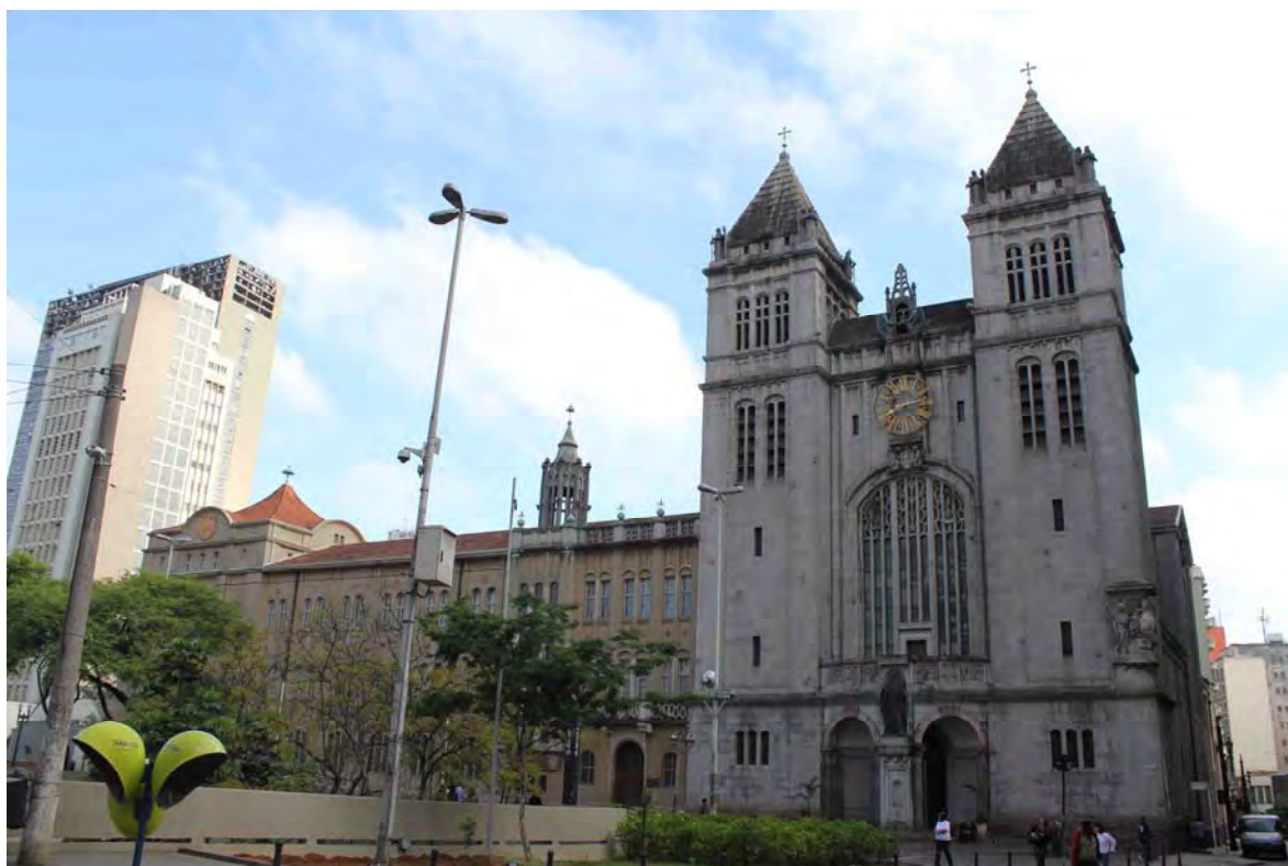
Figura 324. Mosteiro e Basílica de São Bento, São Paulo-SP. Foto Rafael Schunk (2011).
