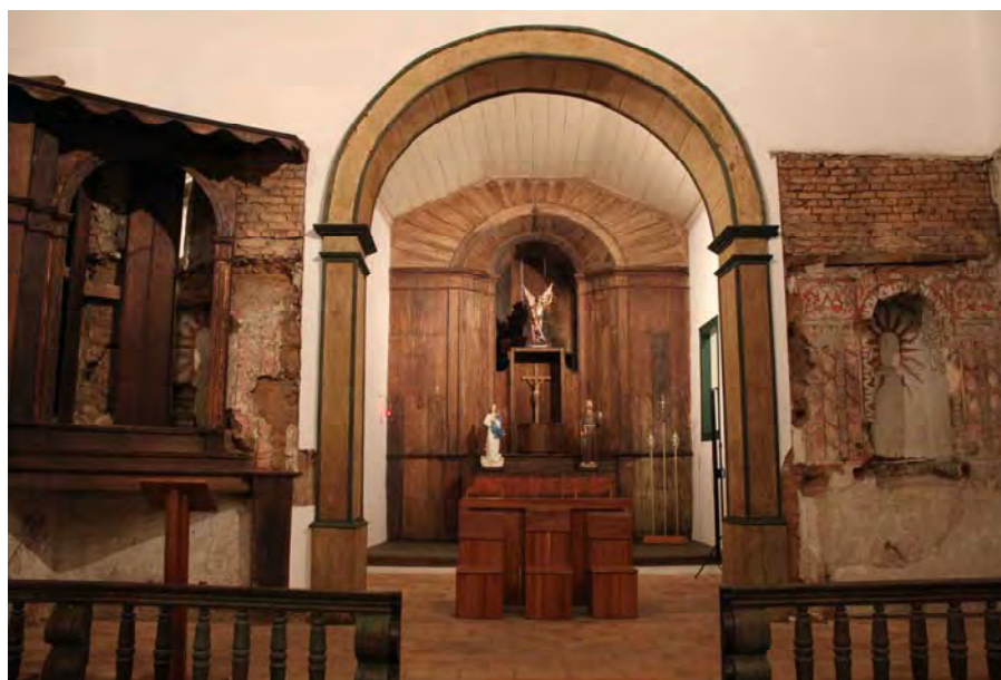
Figura 315. Nave da Capela de São Miguel Arcanjo, Bairro de São Miguel Paulista, São Paulo-SP: redescoberta dos primitivos altares e afrescos pintados na taipa-de-pilão. Meados do século XVII. Processo de restauração escritório de Júlio Moraes, São Paulo-SP. Foto Rafael Schunk (2011).
