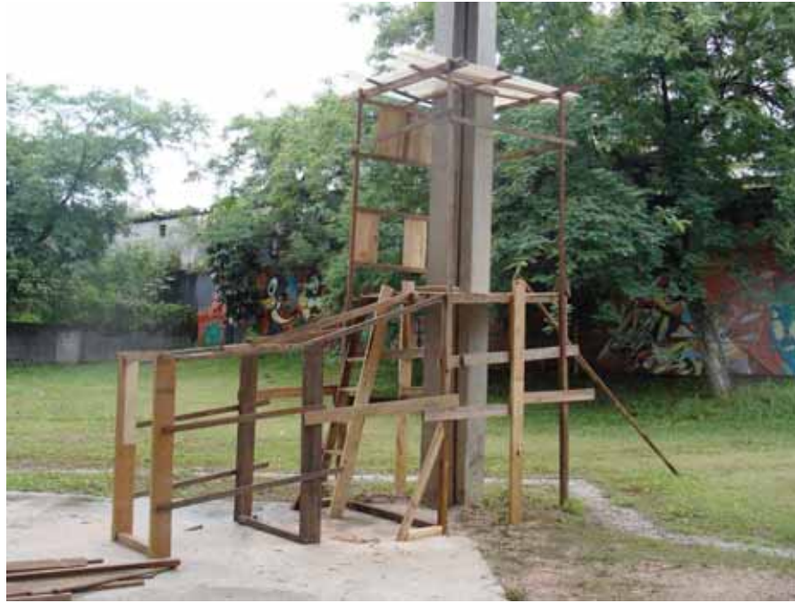
figura 35. Estrutura a obra: On the ground .
