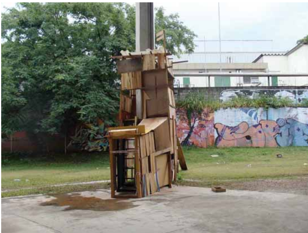
figura 37. Detalhe obra corredor e escada.
