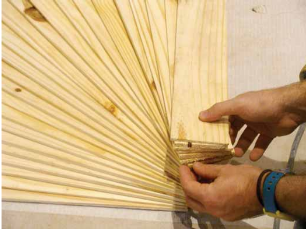
figura 53. detalhe montagem da obra
