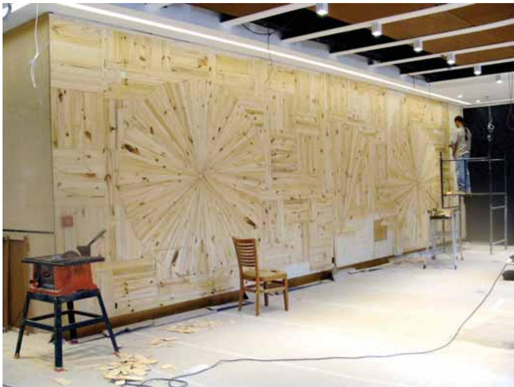
figura 55. Vista geral do processo de construção da Obra
