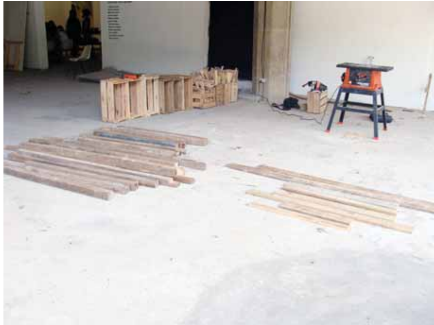
figura 30. Processo da Obra: On the ground.
