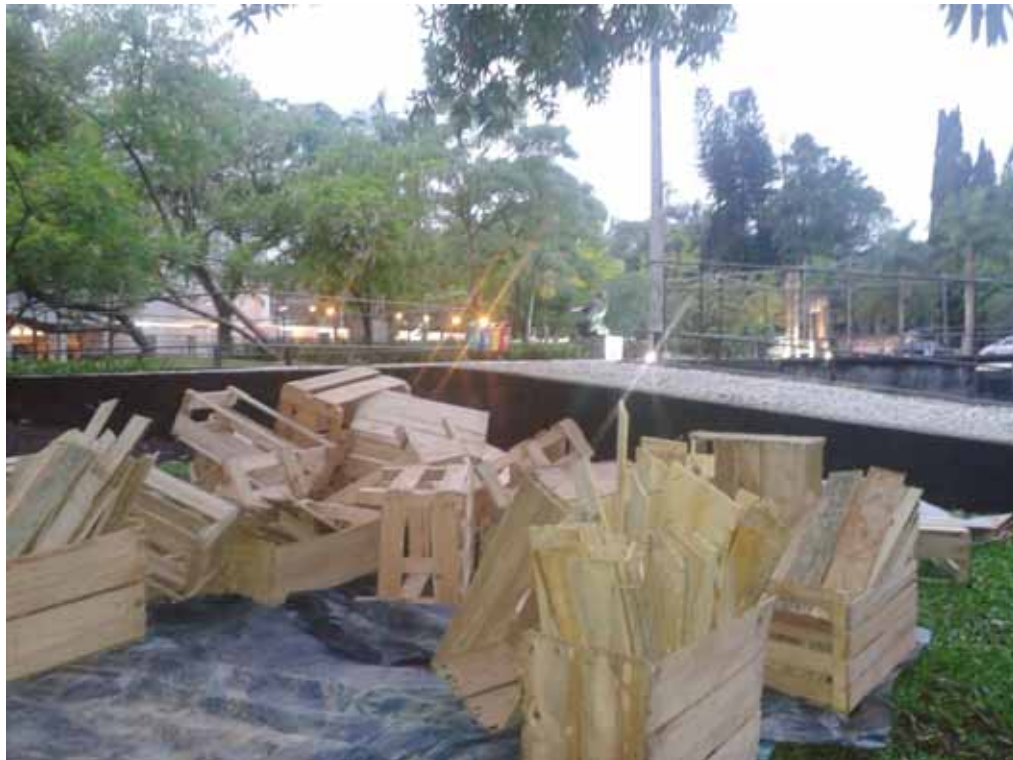
figura 48. Organização dos materiais pré construção da obra.
