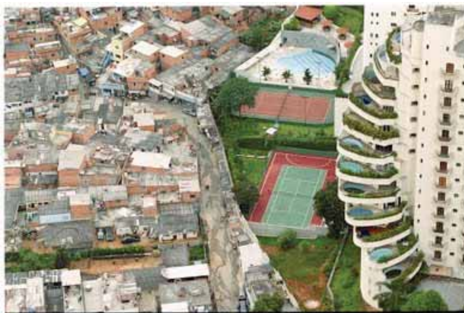
figura 23. Foto aérea da favela do Paraíso-Morumbi, São Paulo, SP
