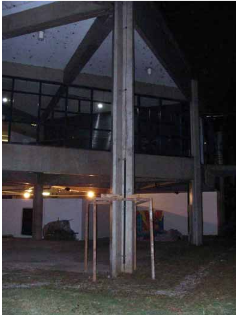
figura 34. Montagem noturna a obra on the ground .
