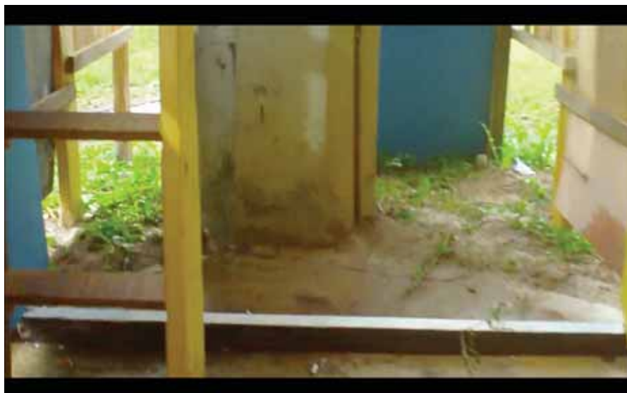
figura 38. Detalhe interno escada à esquerda.
