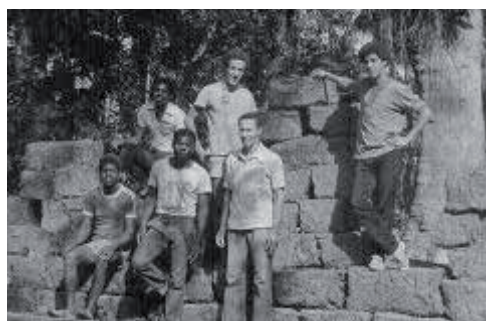
Fig. 92 - Construção do Muro no Parque Lage. Fonte: SILVA, Raquel Martins, 2006.
