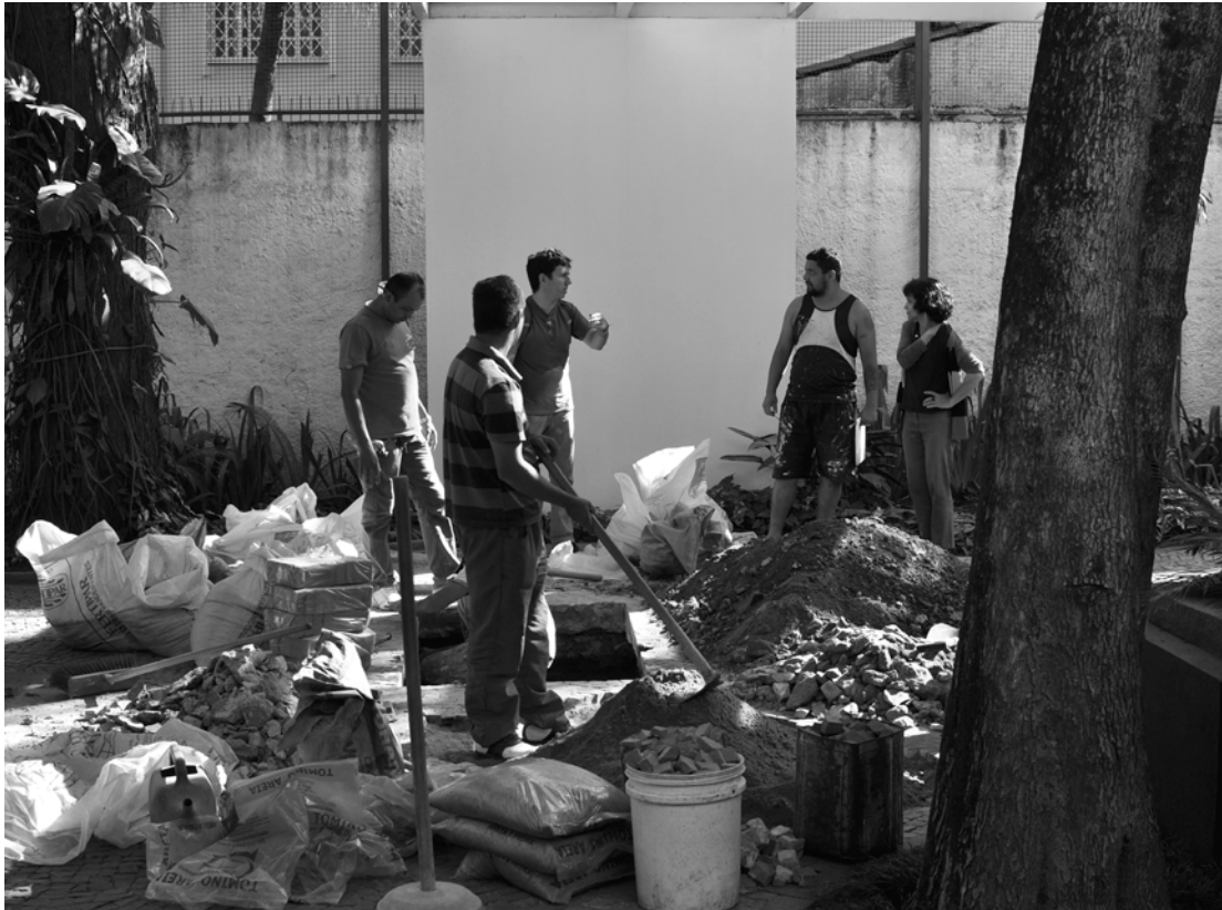
(Registo da montagem da obra Alçapão , Julho 2012 – Museu Lasar Segall) | (Foto: Inês Moura)
