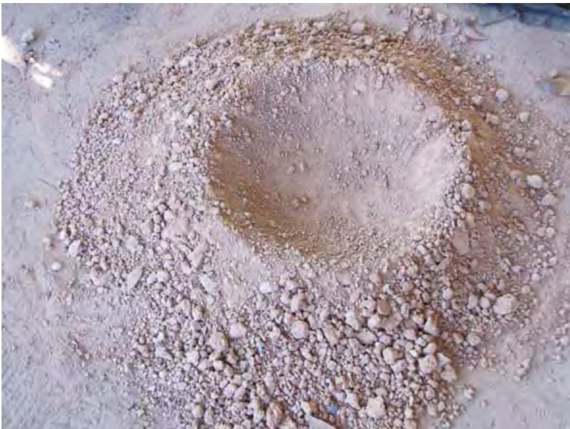
Figura 50 - Molde de apoio preparado com a terra do próprio local – 2010.
