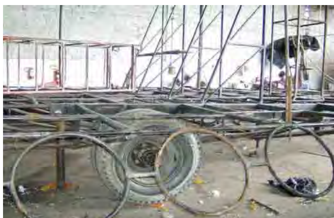
Fig.3 - Ferragem do carro alegórico em construção no barracão da Rosas de Ouro 2006.
