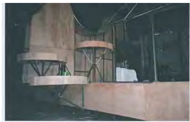
Fig. 4 - Estrutura de ferro do carro alegórico sendo revestida com madeira no barracão da Rosas de Ouro 2006.
