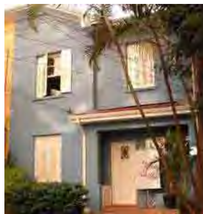
Imagem 11 - Fachada da sede do Instituto Arte na Escola em São Paulo
