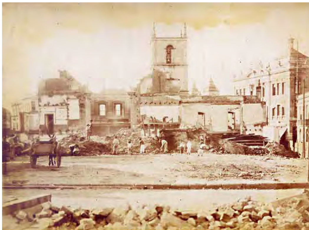
Igreja da Sé (em demolição) Phot. em 13 de Agosto de 1912
