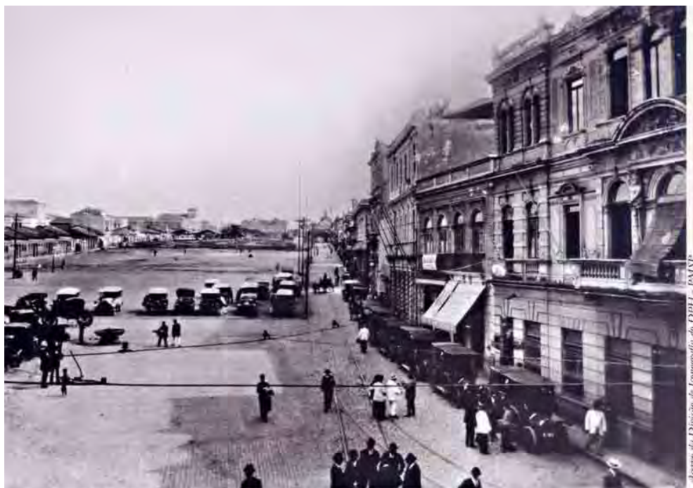
Espaço decorrente das demolições da Sé e dos quarteirões a ela posteriores Fonte: Arquivo do DPH da PMSP
