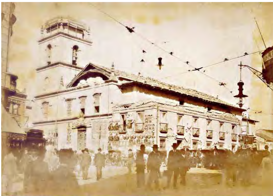
Igreja da Sé (em demolição) Fot. em 27 de Junho de 1912
