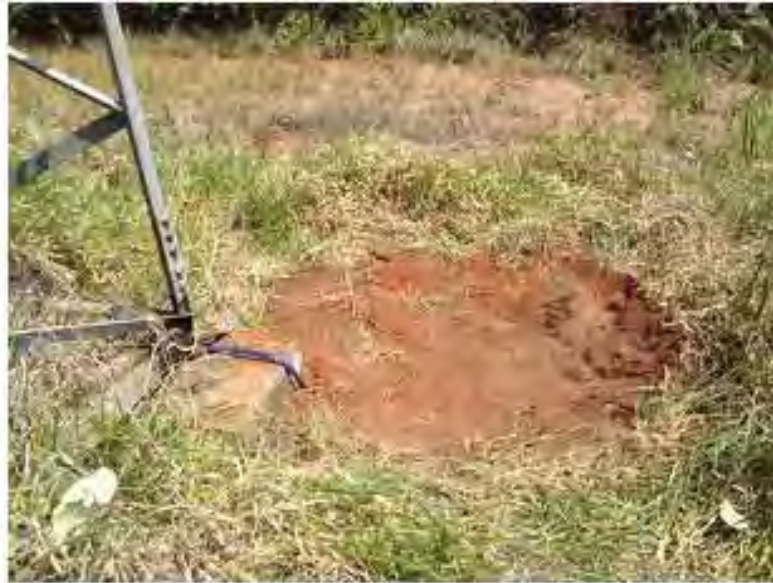
Figura 4.13: Haste instalada na torre 452
