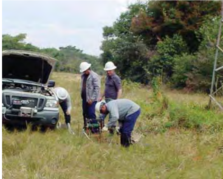
Figura 4.10 - Equipe executando medição de resistividade do solo próximo a torre 452
