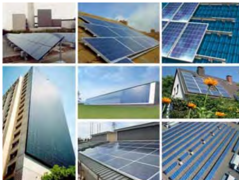
Figura 1.6 — Sistema de geração fotovoltaica de energia elétrica: exemplos de instalações residenciais e comerciais
