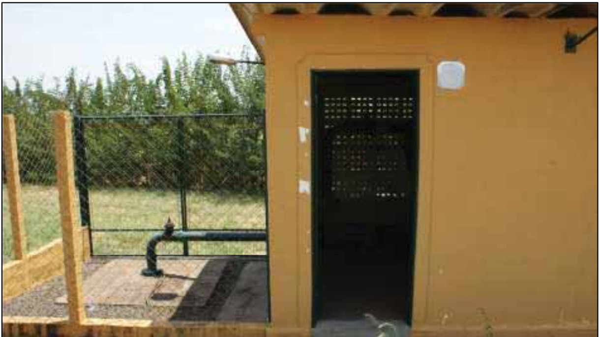
Figura 9. Bombeamento direto do poço à bomba “booster”.
