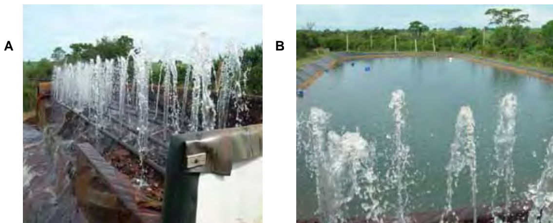
Figura 4. Fotografias do sistema de aerção (A) e do tanque de decantação (B) em momento de limpeza (sem tela de sombreamento).
