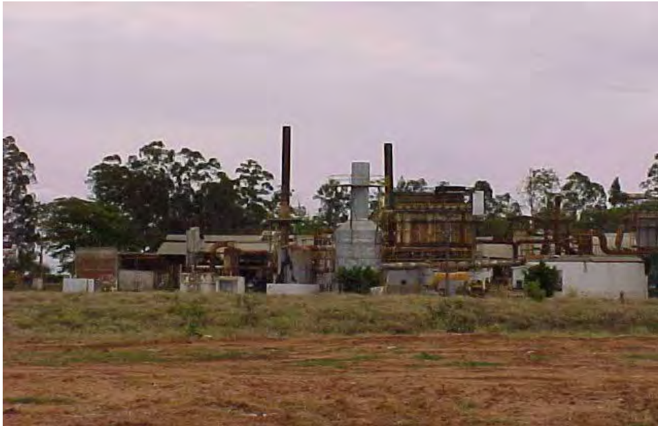
Figura 2. Área industrial (subárea 1) com referências nas coordenadas S 22° 19' 36,9"; W 49° 00' 29,5".
