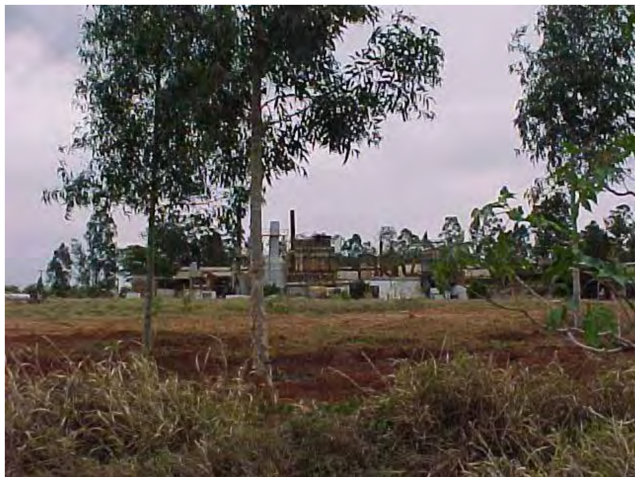
Figura 6. Vista geral da área vizinha aos fornos utilizados na reciclagem do chumbo (subárea 5) com referência nas coordenadas S 22° 19' 43,5"; W 49° 00' 34,1".
