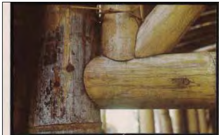
Figura 160 – Conexão com parafuso extensor
