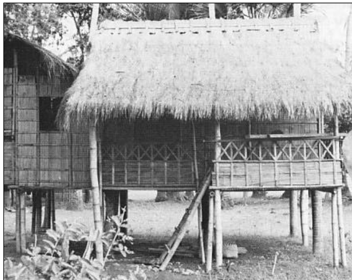
Figura 32 – Elementos de fundação apoiados diretamente no solo Fonte: Dunkelberg (1996)
