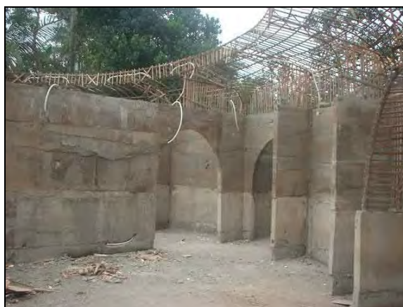
Figura 94 - Ripas de bambu para reforço de concreto em Bali, Indonésia Fonte: Widyowijatnoko e Trautz (2009)
