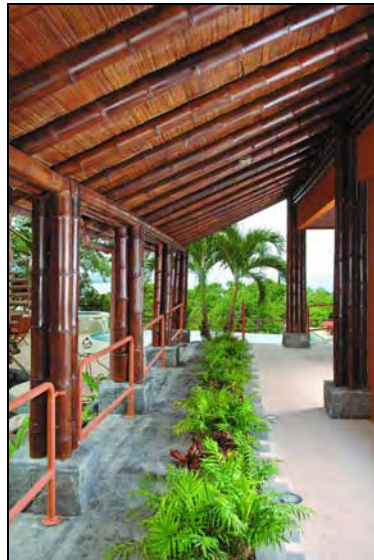
Figura 53 – Fundações em forma de sapatas de concreto
