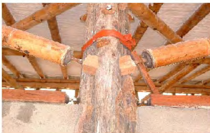
Figura 169 – Conexão de Velez e conexão de Tönges
