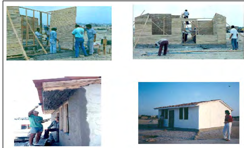
Figura 55 – Sequência de construção de residência com painéis pré-moldados de bambu no Equador
