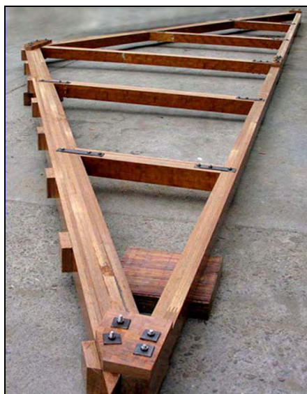
Figura 88 – Ripas de bambu coladas, utilizadas em estrutura de madeira para cobertura
