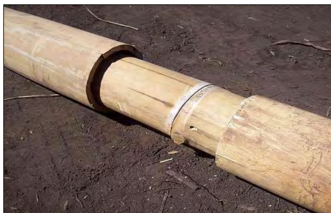
Figura 106 – Conexão a topo com tarugo de bambu
