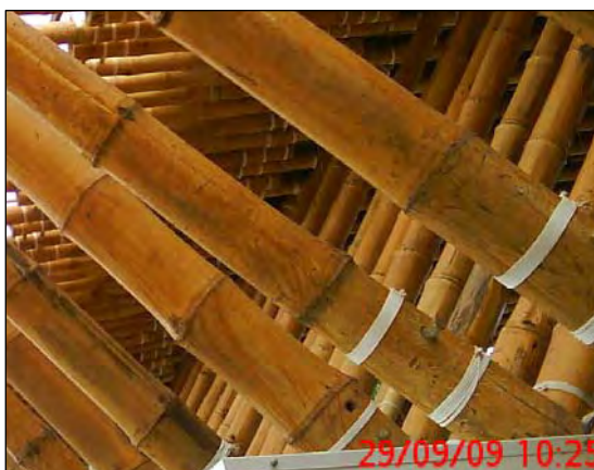
Figura 168 – Utilização de pino metálico e amarração de nylon
