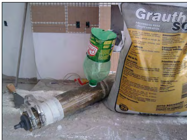
Figura 188 – Conexão com o funil posicionado
