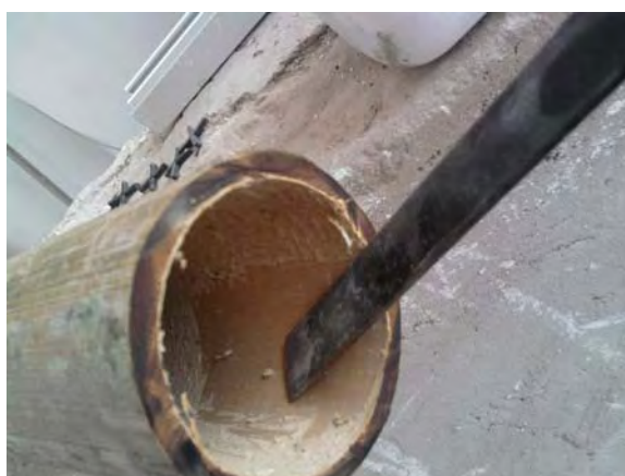
Figura 184 – Limpeza do interior do colmo
