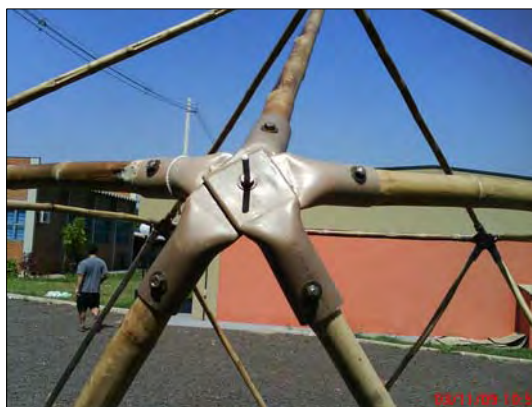
Figura 154 - Conexão por encamisamento dos conectores de plástico
