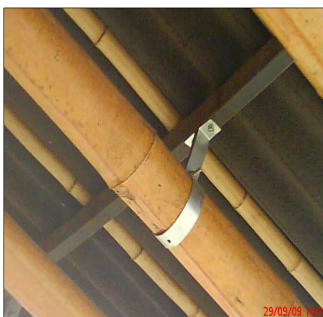
Figura 150 – Conexão por abraçadeiras metálicas
