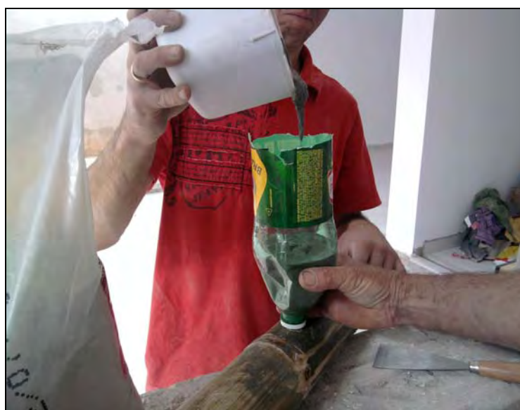
Figura 189 – Grauteamento com utilização de funil
