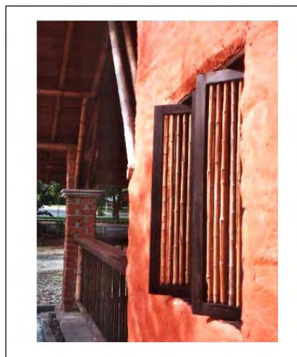
Figura 40 – Janela com grade de bambu
