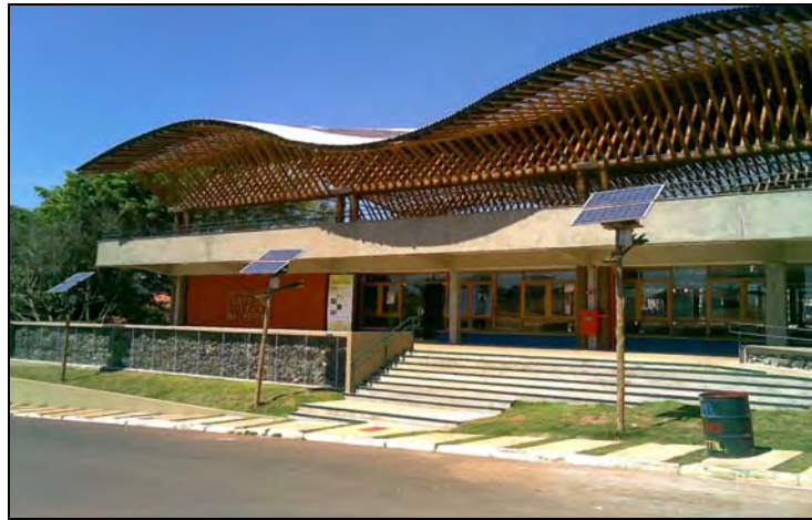
Figura 58 – Estrutura de cobertura do Centro cultural Max Feffer, na cidade de Pardinho, SP
