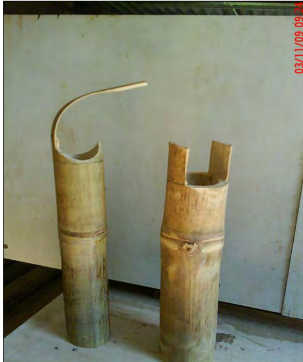
Figura 27 – Corte boca-de-peixe com flange e corte reto
