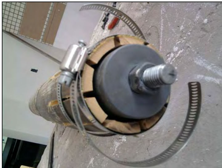
Figura 187 – Instalação de presilhas metálicas
