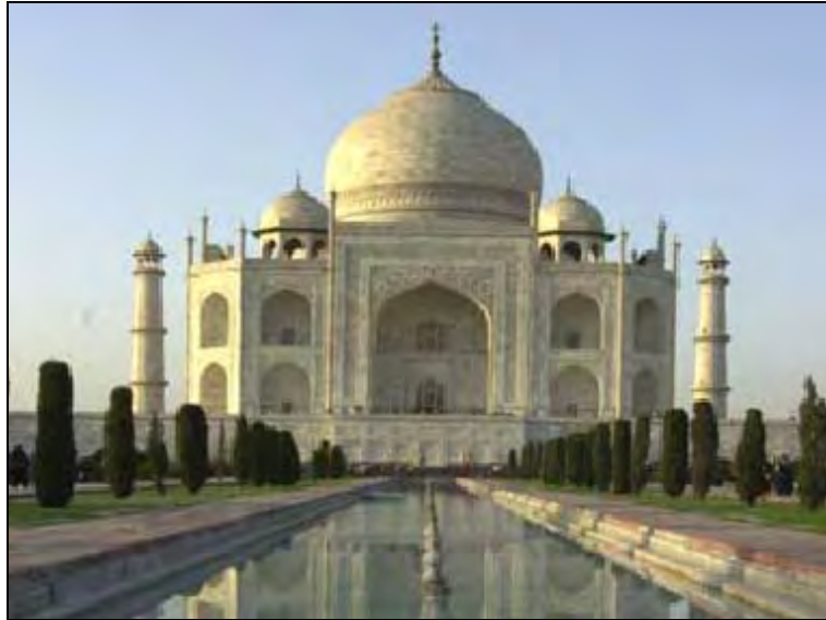
Figura 49 – Palácio Taj Mahal Fonte: Dunkeberg (1996)
