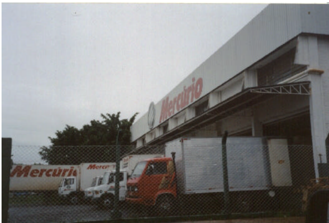
Foto 16. Caminhões 3/4 no momento de embarque para entregas na cidade de São José do Rio Preto: O uso de docas agiliza o embarque e desembarque de mercadorias
