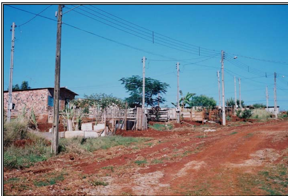
Foto 13: Vista de uma das ruas com erosões e valas abertas
