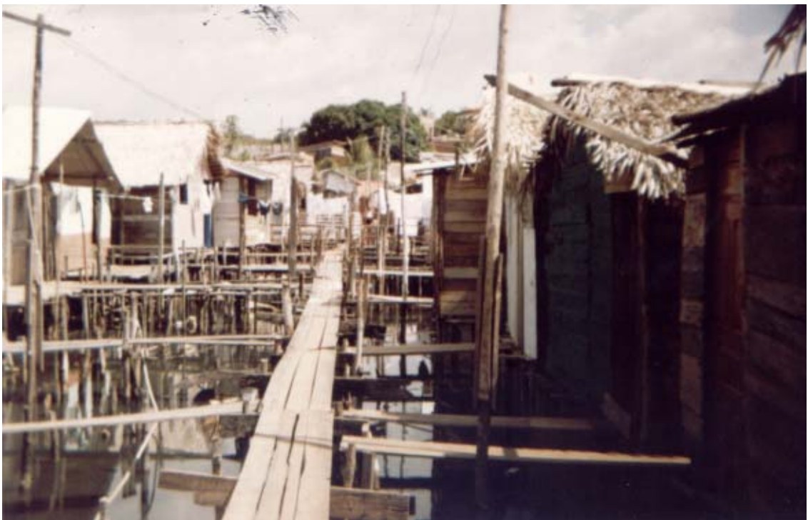
FOTO 1 – As palafitas, situadas no Bairro Ivar Saldanha, São Luís – MA (Rio Anil)
