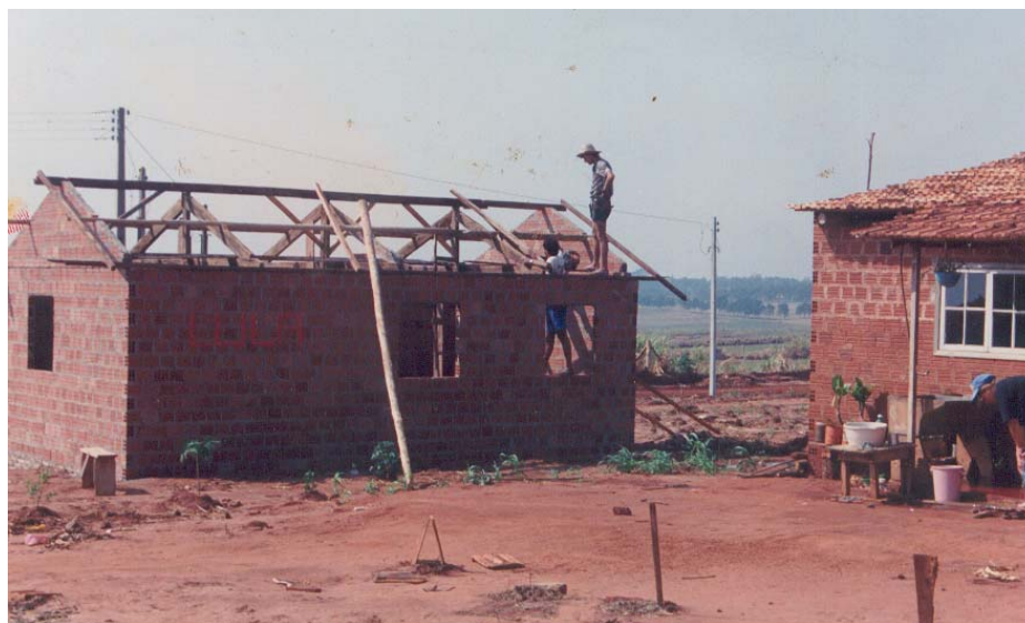
Foto 8 – Construção de casas Fonte: Arquivo da Copavi.
