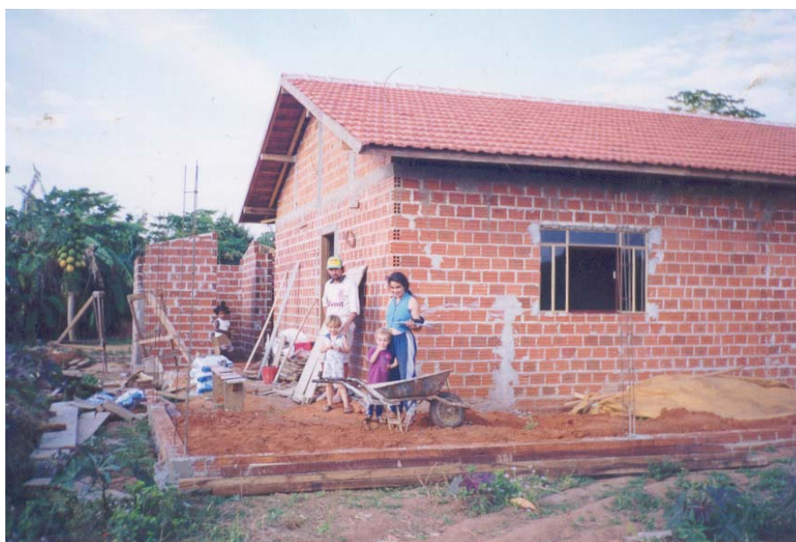
Foto 4 – Casa em fase de acabamento Fonte: VIANA, 2001
