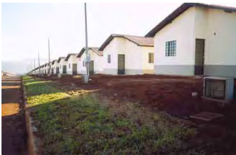
Figura 20. Casas construídas com financiamento da Caixa Econômica Federal na terceira etapa do Complexo Ribeirão Verde (bairro Jd. Professor Antônio Palocci) (18 de jul. 2005).
