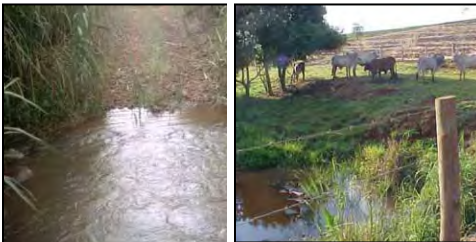
Figura 42. Estrada construída para passagem de caminhões, e corta o córrego do Onça, Figura 43. Acesso de animais causando assoreamento do córrego Mandaguahy.
