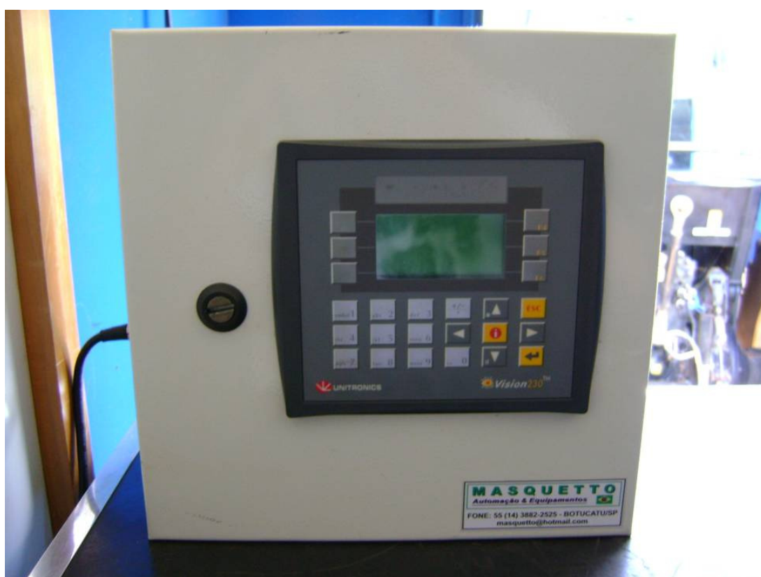
Figura 9 – Controlador Lógico Programável marca UNITRONICS, modelo VISION230.
