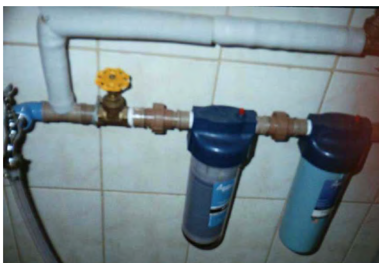
Figura 2. Filtros de carvão ativo para tratamento da água do processo.
