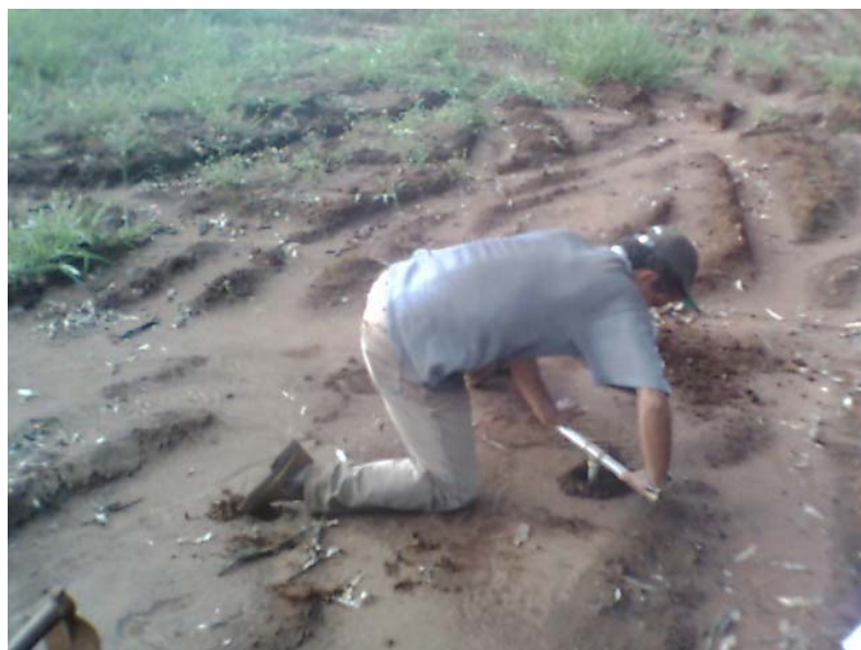
Figura 6 – Instalação de tubo-guia para utilização da sonda de nêutrons.
