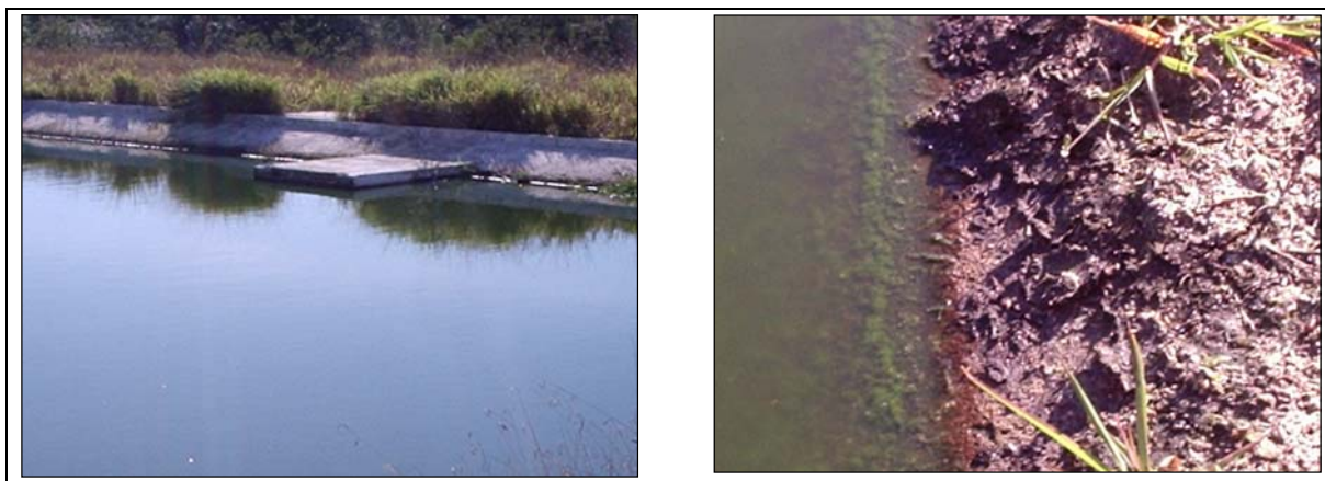
Figura 10. Vista dos pontos de coleta P1 e R1 da lagoa facultativa secundária (última lagoa). Da esquerda para a direita, plataforma com grade submersa e resíduo da borda.
