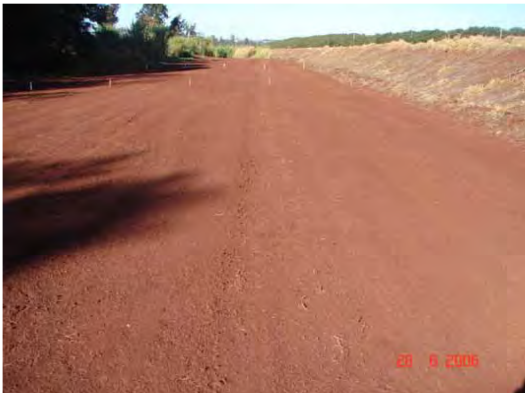
Figura 5 – Pista 3 - Solo firme.
