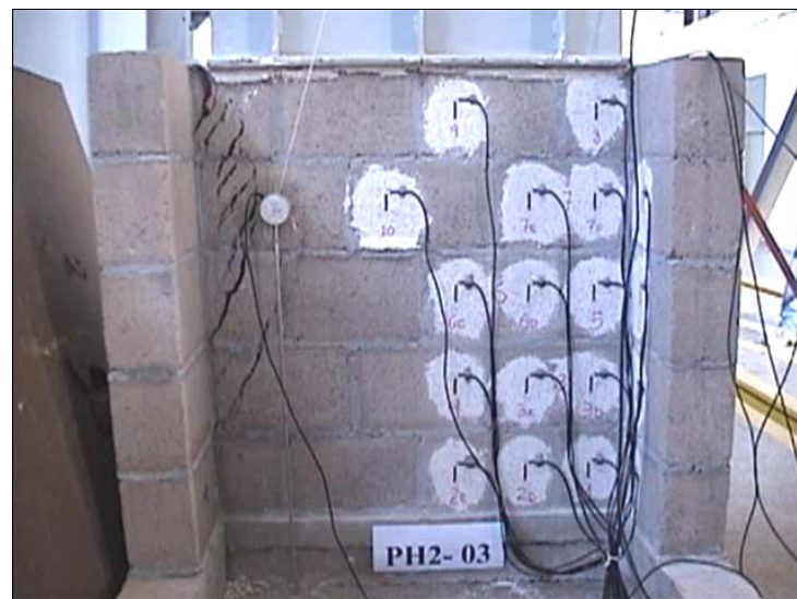
Figura 10.23 – Formação de fissuras na região da ligação
