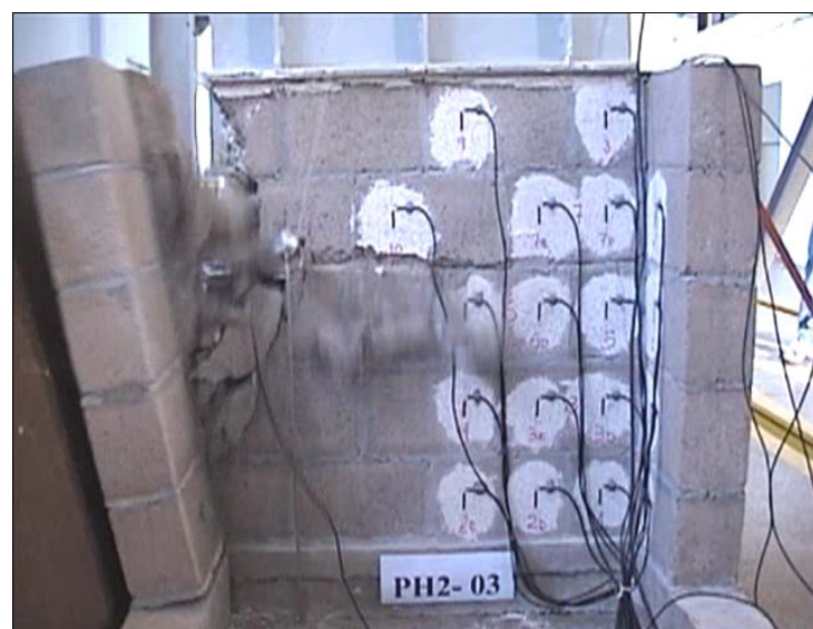
Figura 10.24 – Instante da ruptura 1
