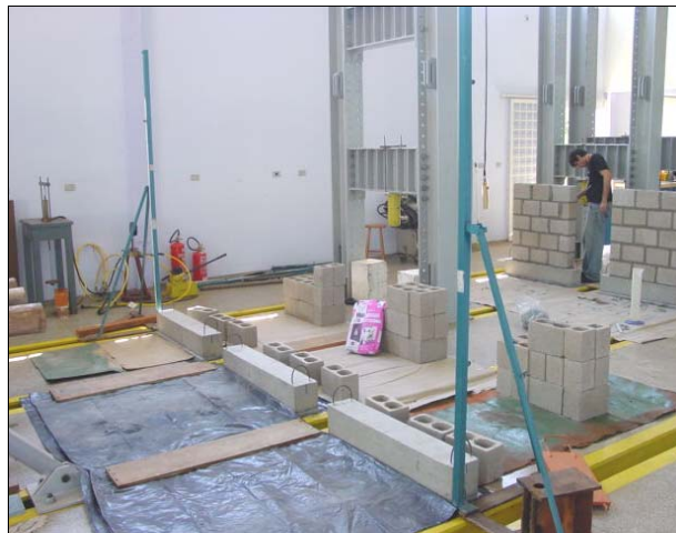
Figura 6.1 – Escantilhões para auxiliar na construção das paredes
