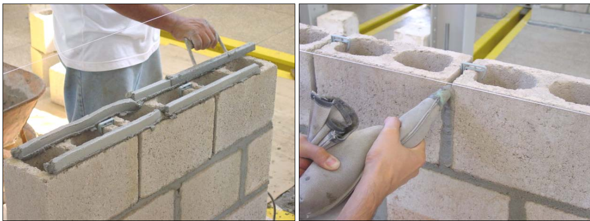
Figura 6.3 – Execução das juntas horizontais e verticais
