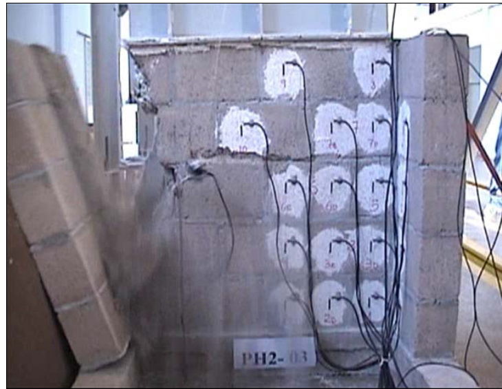
Figura 10.25 – Instante da ruptura 2
