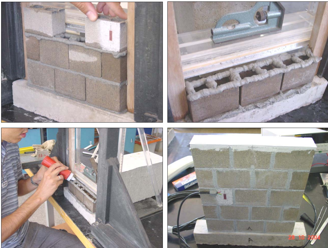
Figura 6.11 – Montagem das paredes
