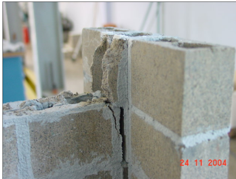
Figura 10.41 – Detalhe da forma de ruptura – blocos cisalhados
