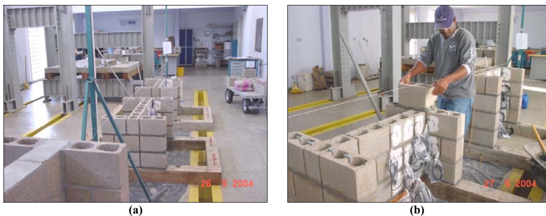
Figura 8.4– (a) Escantilhão e (b) assentamento de blocos instrumentados
