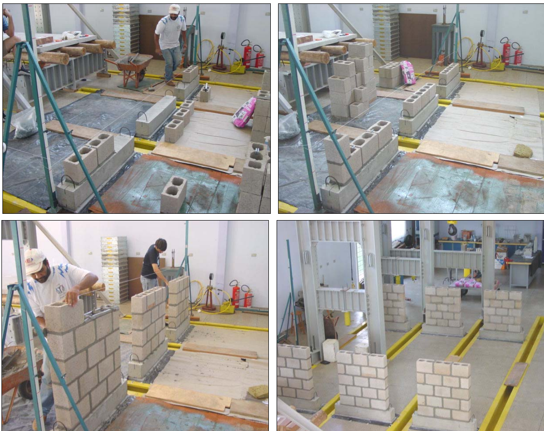
Figura 6.2 – Sequência de montagem das paredes
