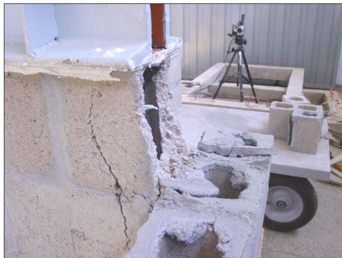
Figura 10.2 – Forma de ruptura parede H tipo 1
