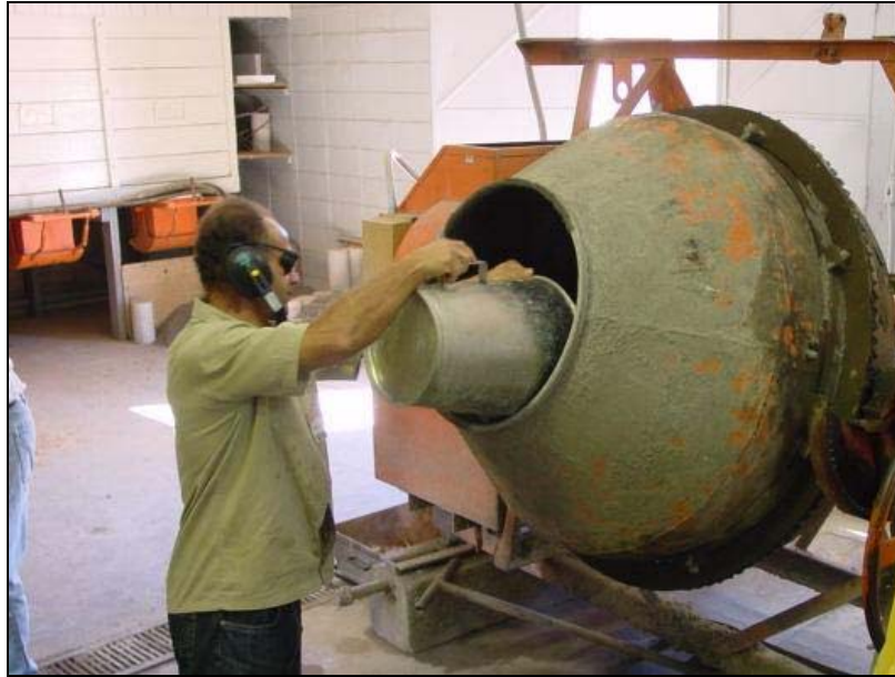
Figura 4.2 - Detalhe dos materiais sendo depositados na betoneira
