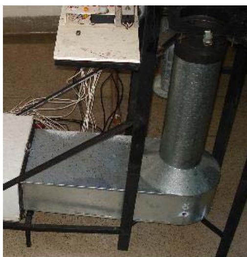
Figura 3.8: Câmara de distribuição de ar
