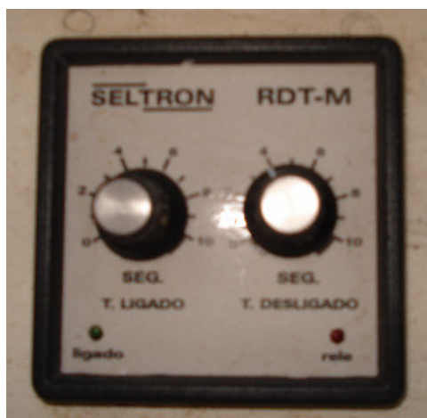
Figura 3.6: Relê de tempo utilizado para controlar os intervalos de pulsação.
