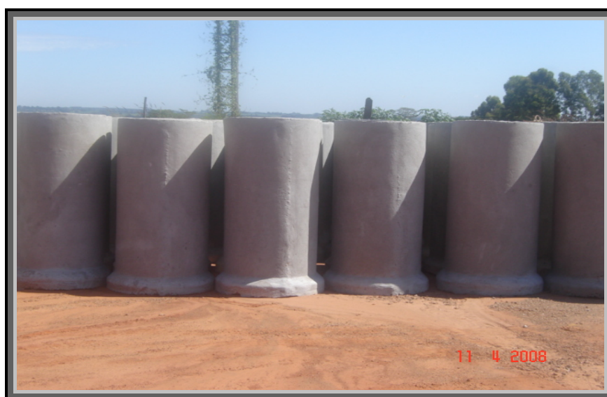
Figura 27: Armazenamento de tubos de concreto na posição vertical Fonte: CASO CONSTRUTORA LTDA (2008)
