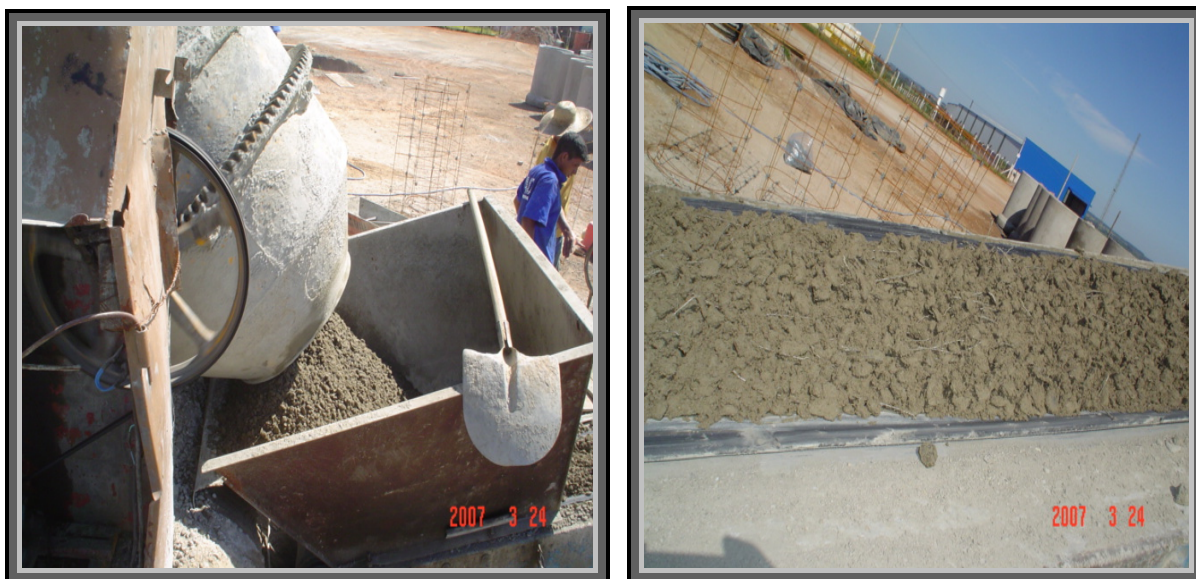
Figura 19: Fabricação do concreto e manuseio deste até o local do sistema produtivo através de esteira rolante
