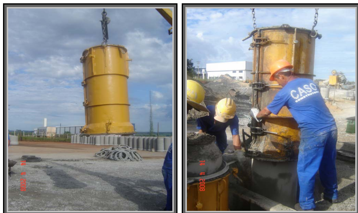
Figura 18: Colocação da fôrma externa, que contém a armadura e o anel, na fôrma interna (é o vibrador)
