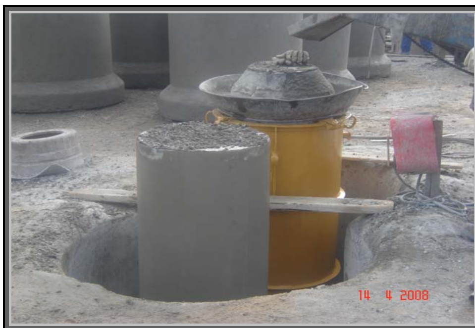
Figura 13: Local onde ficam as fôrmas internas (vibradores)
