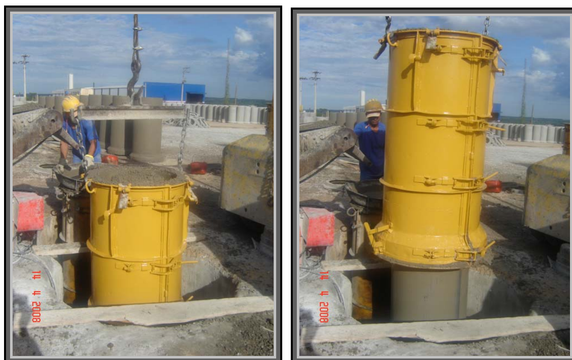
Figura 22: Içamento do tubo de concreto para ser levado até o local de cura
