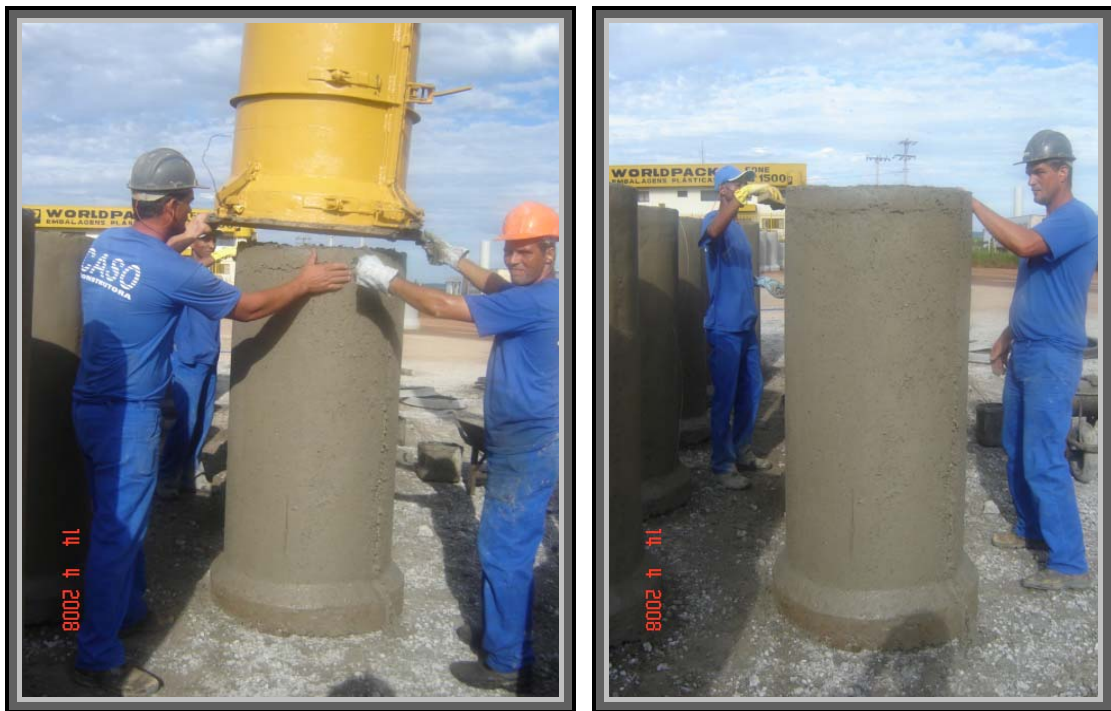
Figura 25: Acabamento externo do tubo, sendo que neste momento o tubo é sustentado apenas pelo anel
