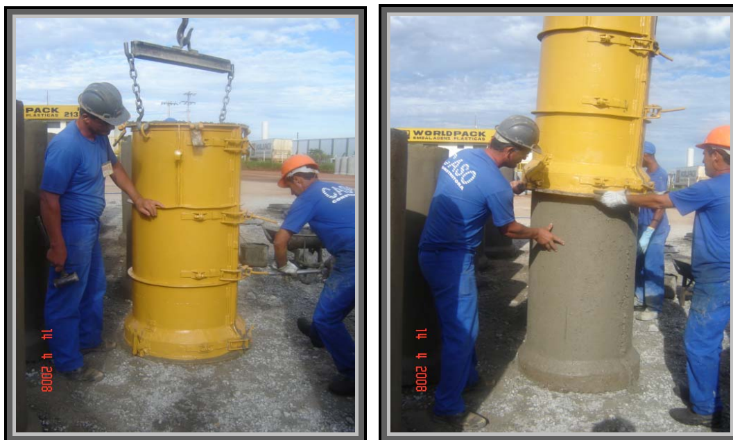
Figura 24: Colocação do tubo no local de cura e retirada da fôrma externa
