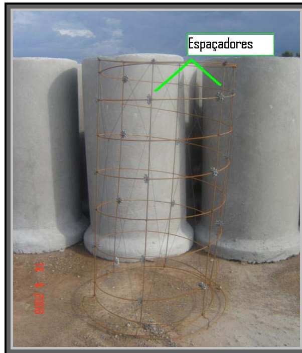
Figura 11: Armação de aço para tubos de diâmetro de 600 mm Fonte: CASO CONSTRUTORA (2008)
