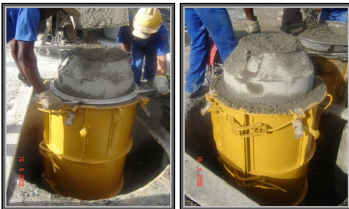
Figura 21: Adensamento do concreto através do sistema produtivo por vibração
