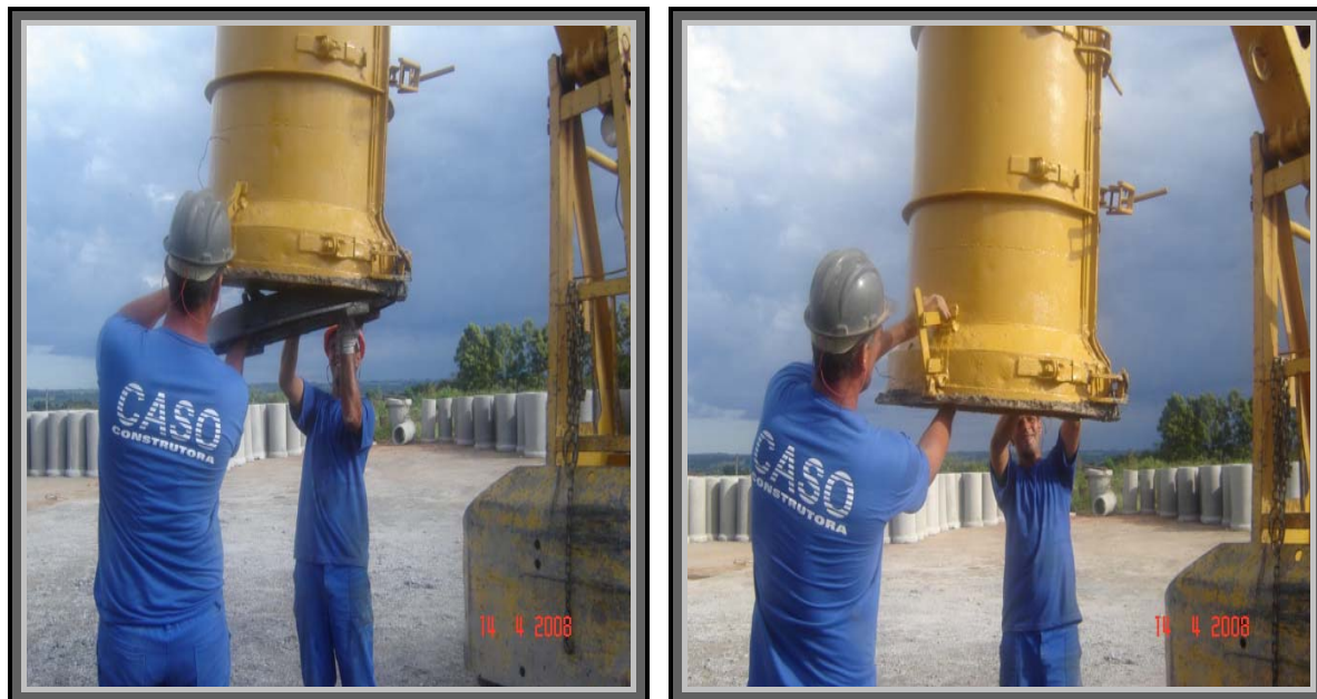
Figura 17: Encaixe da armadura e do anel na fôrma externa
