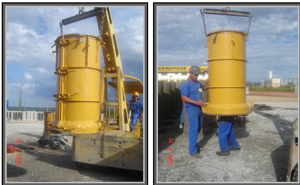
Figura 23: Acabamento por dentro do tubo
