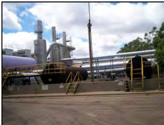
Figura 8: Vista parcial do sistema de filtragem dos gases poluentes Fonte: Crédito da autora.
