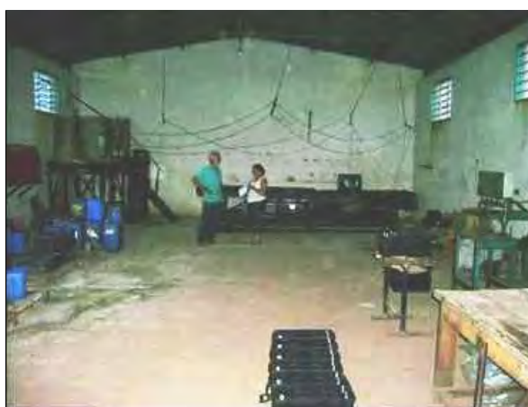
Figura 28: Vista parcial do interior do galpão Fonte: Crédito da autora.
