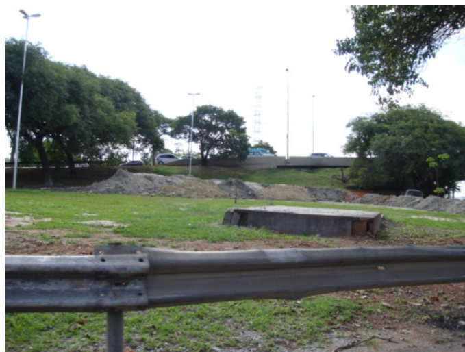
Figura 53 – Deposição irregular no jardim da alça da ponte Cidade Universitária
