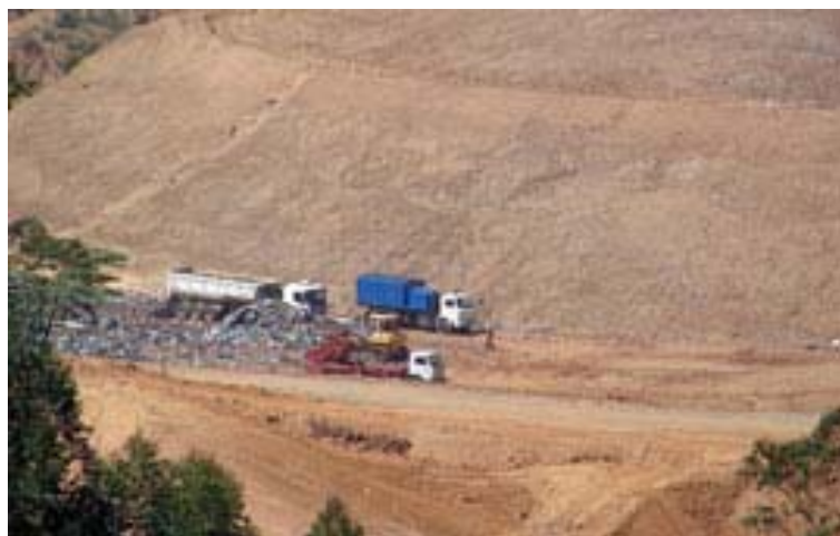
Figura 51 – CTR Epron (Caieiras) Fonte: Santini (2007)
