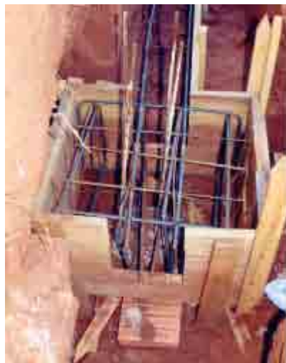
Figura 5.14 – Aço da armadura de concreto
