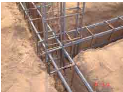
Aço da fundação conectado ao aço da coluna e dos baldrames
