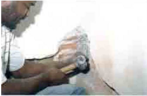
Abrindo o concreto da coluna para conectar o condutor de aterramento em estrutura existente
