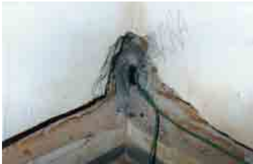
Ponto de conexão dos condutores de aterramento no aço da coluna
