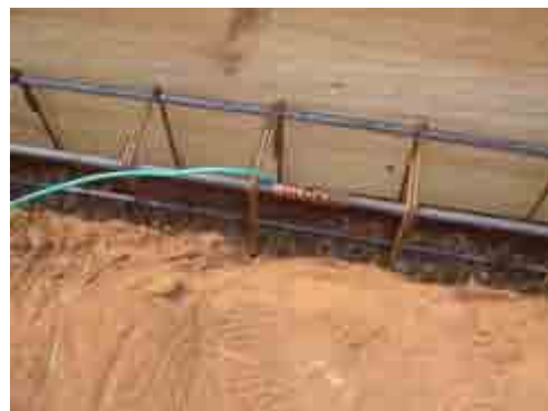
Figura 5.13 – Detalhes do ponto de força com PE conectado ao aço
