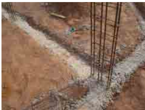
Figura 5.13 – Detalhes do ponto de força com PE conectado ao aço
