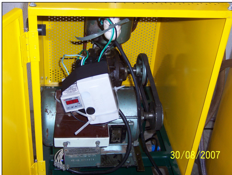
Foto 4- Bomba pneumática e Compressor.
