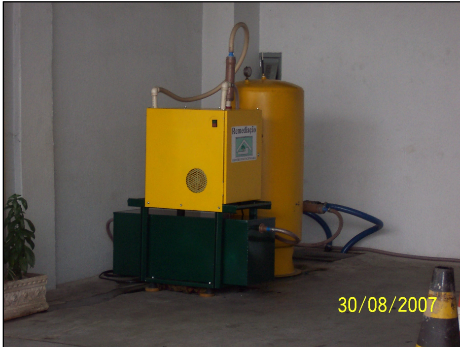
Foto 1- Sistema de Remediação MPE.
