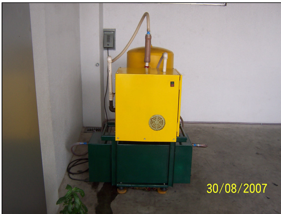
Foto 2- Sistema de Remediação MPE.
