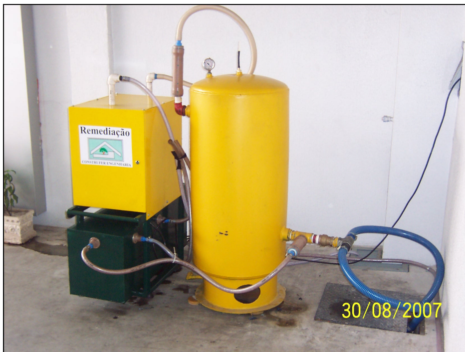
Foto 3- Sistema de Remediação MPE.
