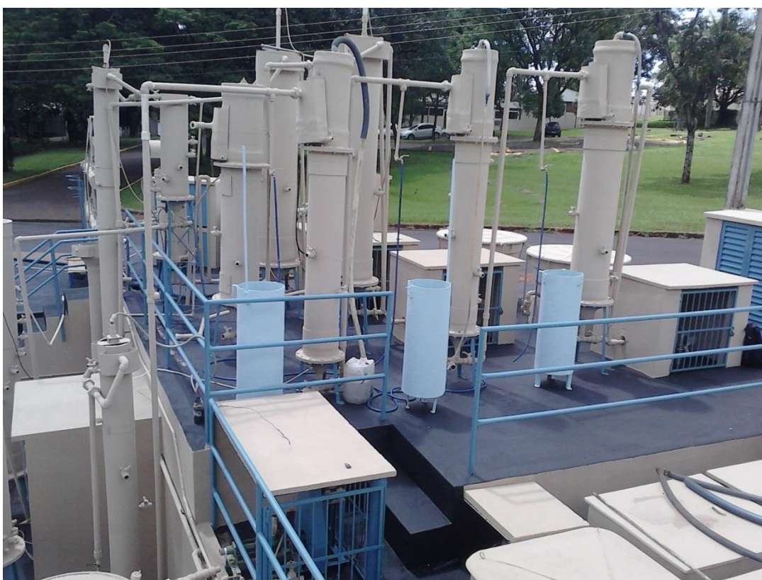
FIGURA 6: Imagem do sistema de tratamento composto pelo reator ABR (C1 + C2), filtro aerado submerso (FAS) e USB anóxico, nas instalações do Departamento de Engenharia Rural da UNESP, Campus de Jaboticabal.
