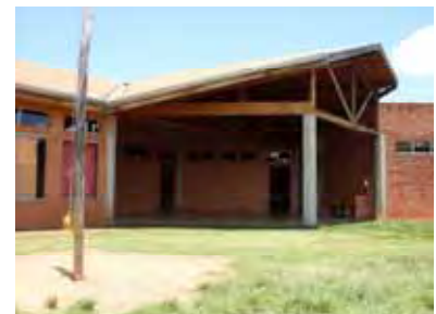
Fig. 13: Bloco de salas de aulas
